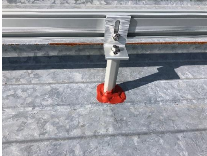
Figura 3.5 Anclaje de estructura coplanar
