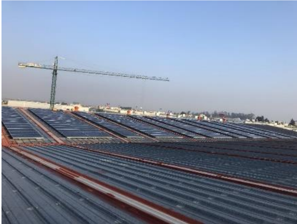
Figura 3.7 Paneles instalados en el sitio
