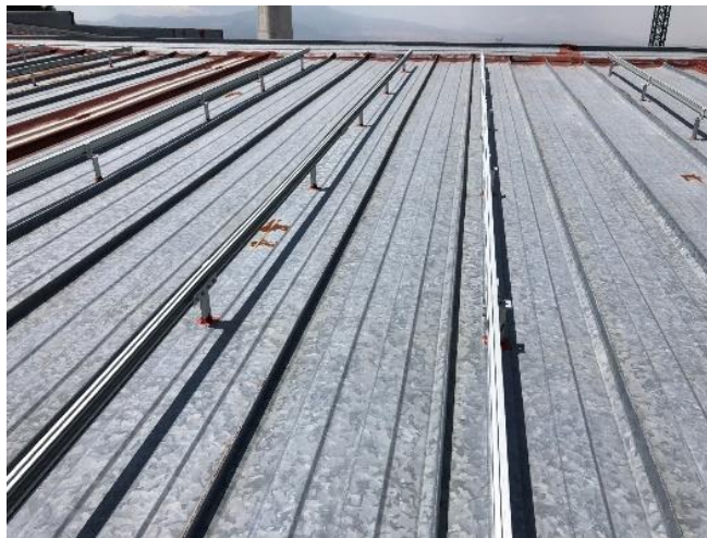
Figura 3.6 Estructura finalizada en el sitio
