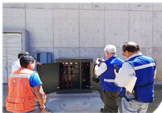
Supervisión de los trabajos de media tensión
