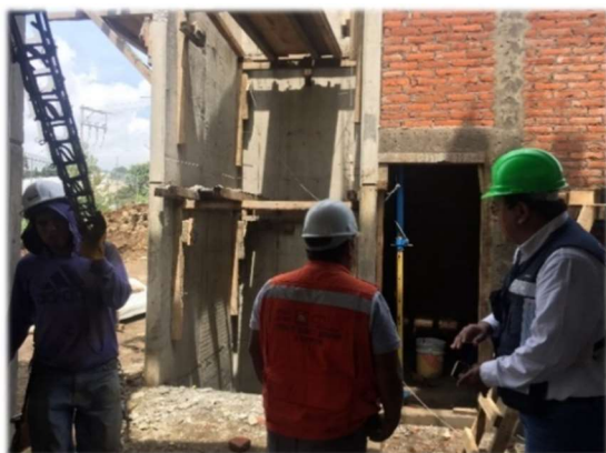
Supervisión de los trabajos cuidando el aspecto ambiental
