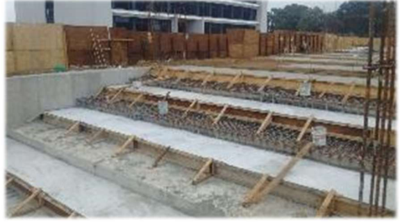
Ejecución de los trabajos
