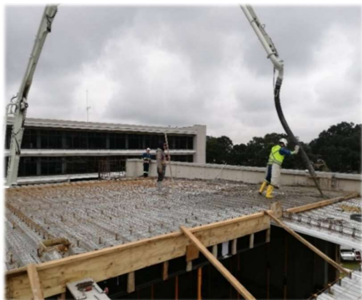
Supervisión de los trabajos de colado en losa
