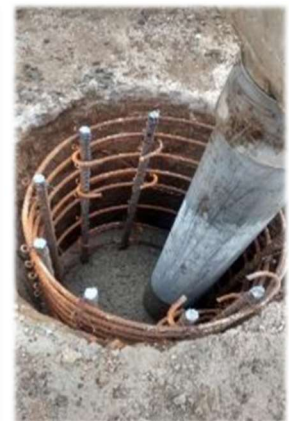
Colado de pilas
