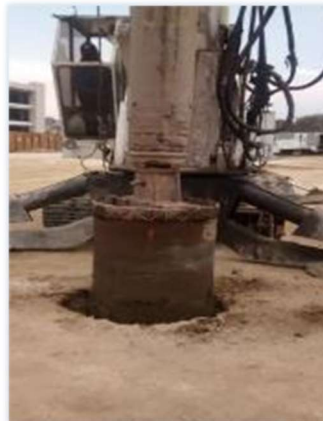
Perforación para pilas
