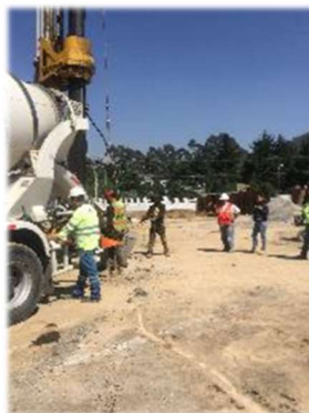
Colado de pilas
