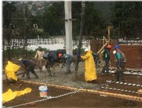
Colado de firmes
