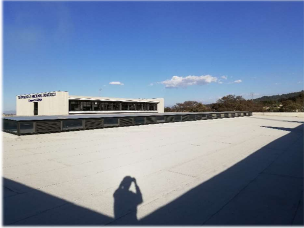
Azotea del edificio
