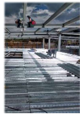
Montaje de estructura y losacero
