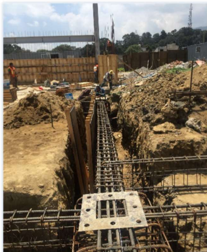
Armadado de contratrabe en sustitución de la pila
