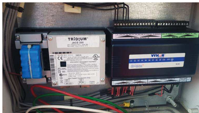
Ilustración 4.2 Fotografía tomada en campo del PLC (izquierda) a controlar conectado a una tarjeta de expansión(derecha).
