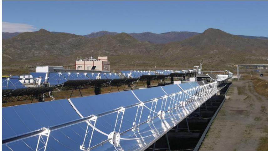
Figura 21. Colectores solares cilindro-parabólicos.
