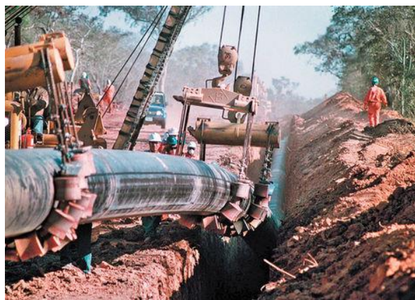
Figura 1.13 Gasoducto GASBOL, realizado en 2000 con tubo de conducción Tenaris [35]
