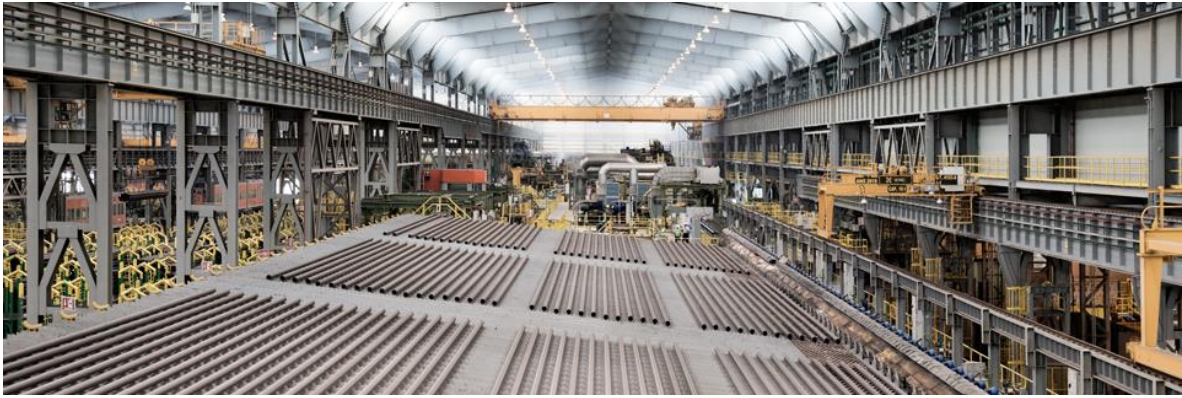
Figura 1.2 Fábrica De Tubos 3 en TenarisTamsa [4]
