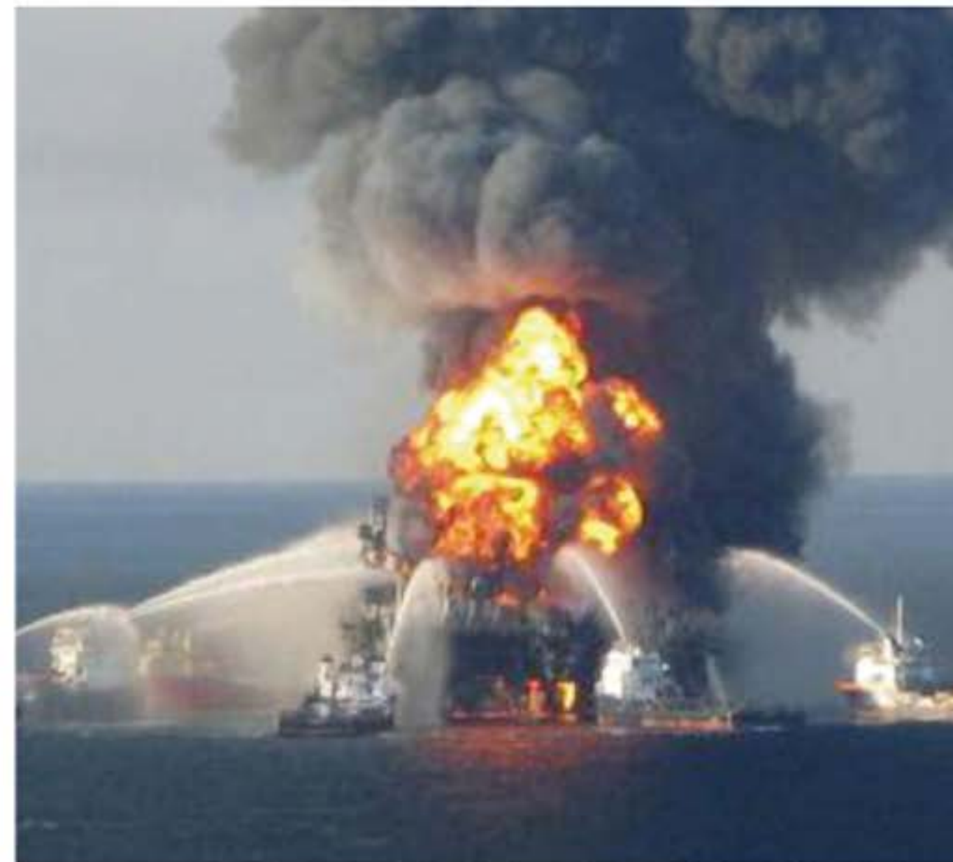
Imagen 4.82. Campo Macondo donde se Perdieron las Barreras del Pozo. (Fuente: Tomada de equipos de perforación)
