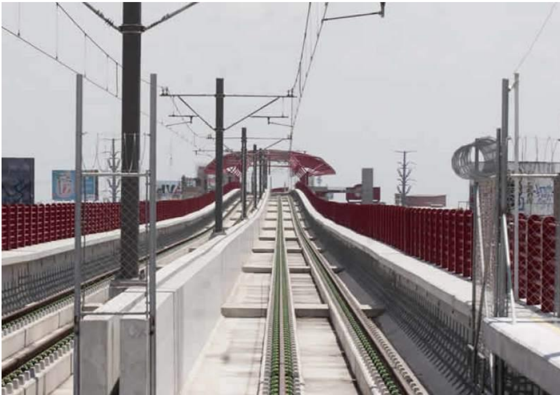
Figura 25 Avance en obras del Metrorrey línea 3 en Monterrey, Nuevo León
