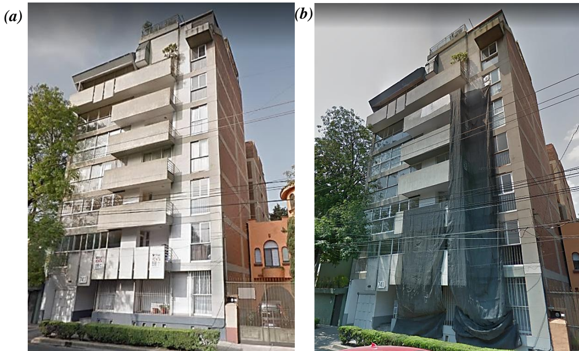
Figura A2. Edificio considerado DS 2 : (a) Vista exterior del edificio previo al sismo https://bit.ly/2TjVqQi , (b) Vista del edificio posterior al sismo, (c) Daños en muros exteriores (d) Detalles de daños observados en cubo interior del edificio, (e) Fisuras mayores a 5 mm en muros de fachada, (f) Leves fisuras en muros exteriores transversales, (g) Fisura por cortante en muro de mampostería, (h) Fisura por separación de juntas en muros de mampostería, (i) Fisuras mayores a 5 mm en muros de mampostería, vista desde el cubo de iluminación, (j) Fisuras menores a 2 mm en elementos de concreto verticales, y (k) Fisuras menores en muros diafragma colindantes.
