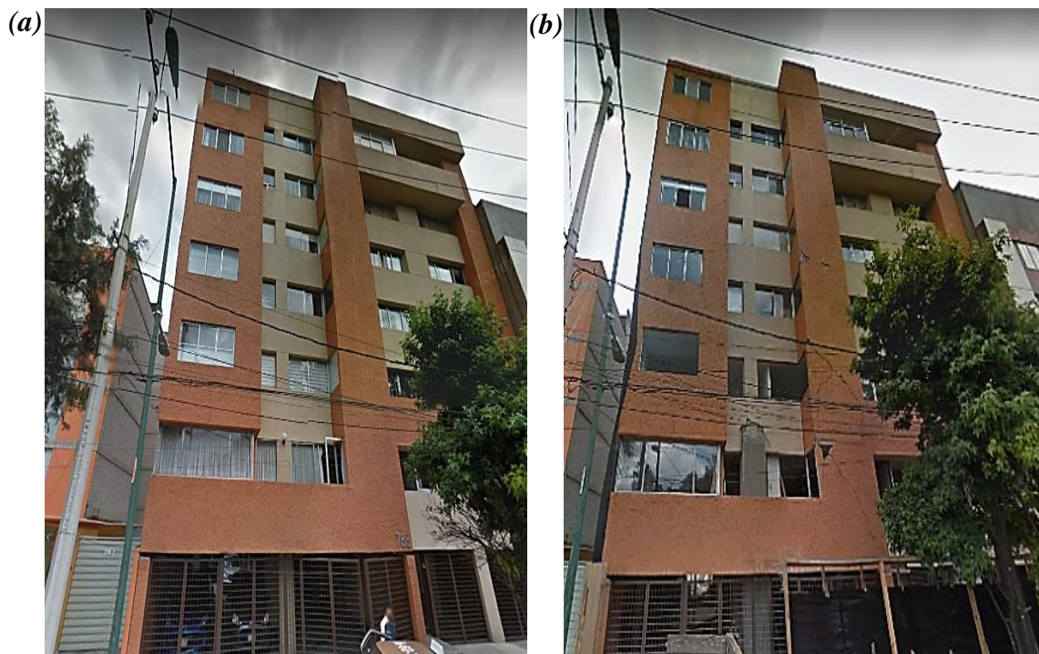
Figura A3. Edificio considerado DS 3 : (a) Vista exterior del edificio previo al sismo https://bit.ly/3628pu3 , (b) Vista del edificio posterior al sismo, (c) Daños en muros exteriores de fachada (d) Detalles de daños observados en la entrada principal del edificio, (e) Fisuras mayores a 5 mm en muros laterales, (f) Fisuras mayores a 5 mm en elementos de concreto, (g) Detalle de daños en columnas, (h) Detalle de daños en planta baja, (i) Detalle de daños en muros interiores, y (j) Daños en muros exteriores laterales
