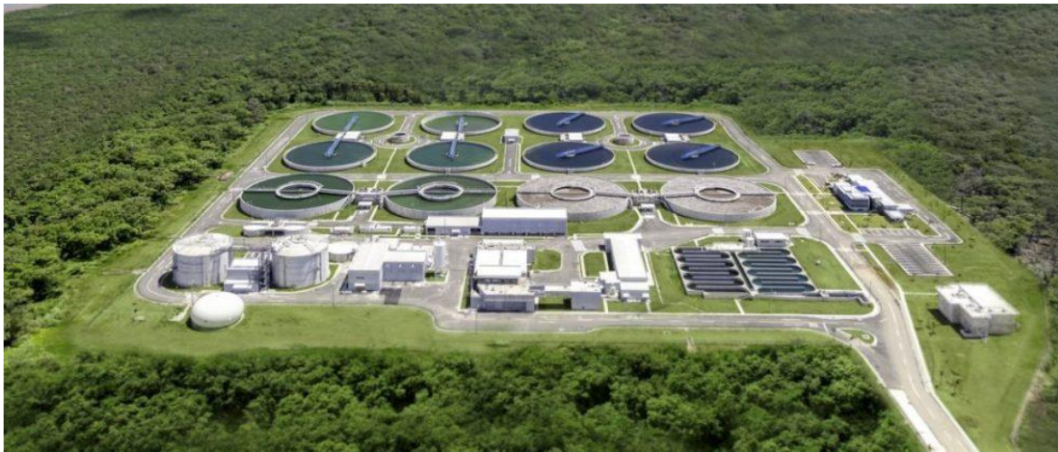
Figura 2.4 Planta de tratamiento de agua residual
