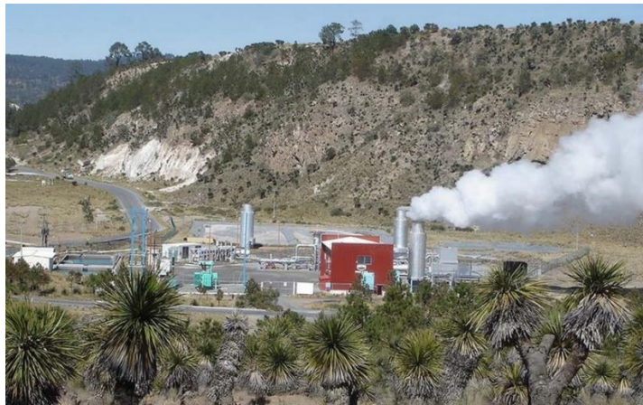
Fig. 16 Campo geotérmico Los Humeros, Puebla, México (tomada de Los Humeros volcán que produce energía, Milenio.com).
