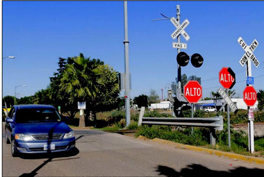
Figura 8. Protecciones en Cruce a Nivel.
