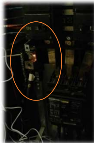
Ilustración 2. Falso contacto en la zapata a la barra del neutro
