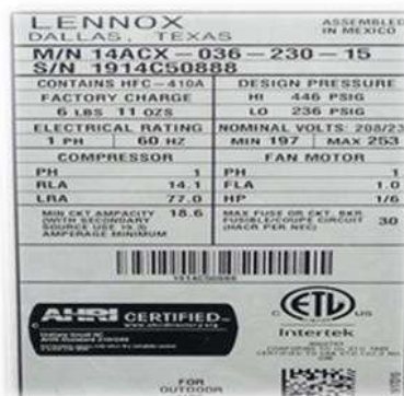
Ilustración 12. Datos de placa del equipo de aire acondicionado número 1
