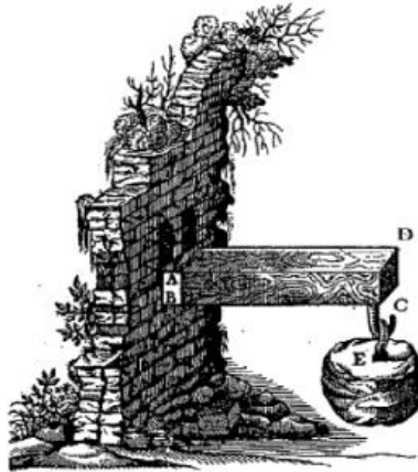
Figura 1.5 Bosquejos de ensayos de resistencia de Galileo (Gómez I., 2008)
