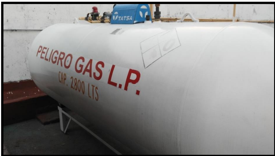
Imagen 3: Tanque de gas natural
