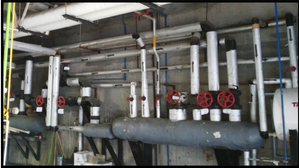
Imagen 2: Salidas de vapor
