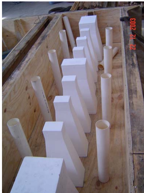
Figura 2.16. Configuración de elementos p/dejar huecos
