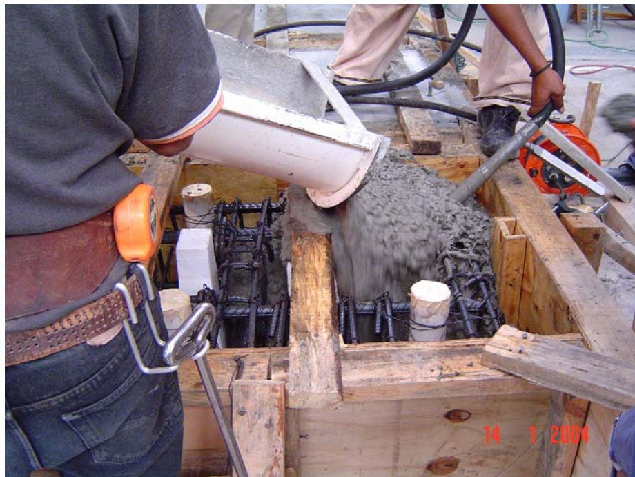
Figura 2.18. Colado de cimentación
