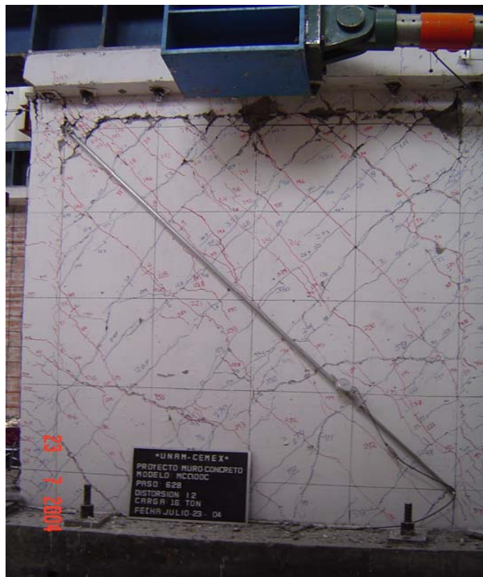
Figura 3.48. Estado final del muro MCC100C
