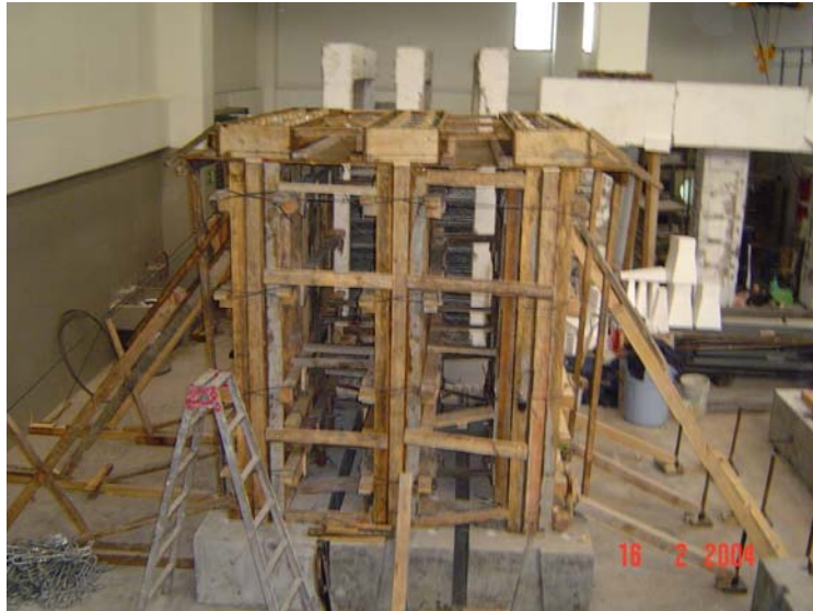
Figura 2.24. Muros cimbrados antes del colado
