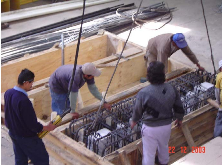
Figura 2.17. Colocación de acero de refuerzo
