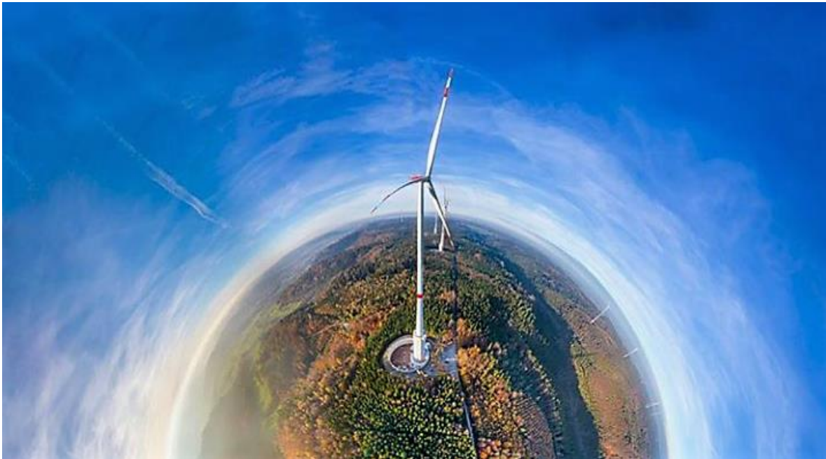
Figura 12. Turbina eólica General Electric (GE) en Alemania 1 .
