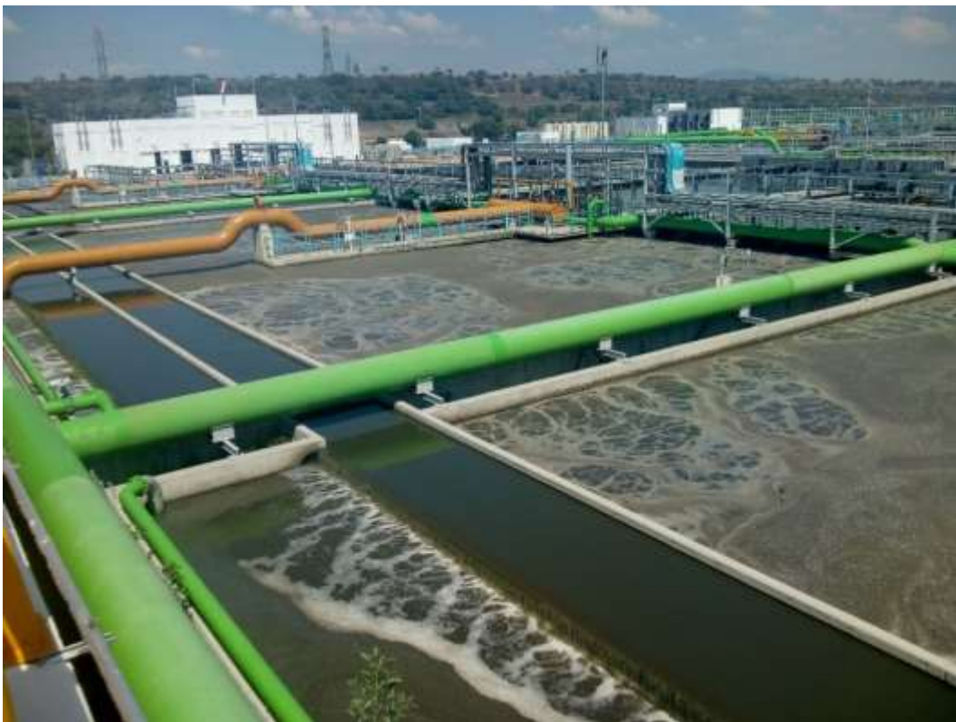
Figura 40. Proceso de lodos activados
