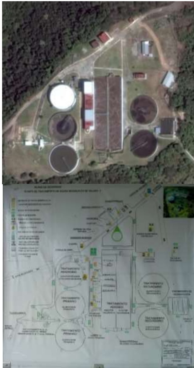
Figura 27. Vista aérea (arriba) y plano de la PTAR Xalapa I (abajo)
