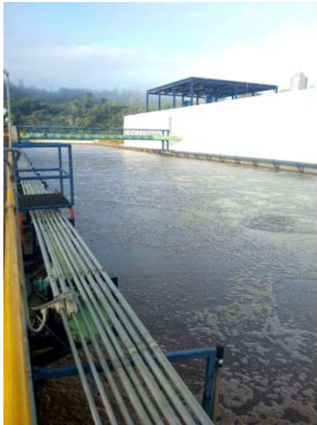
Figura 29. Tanque de aireación
