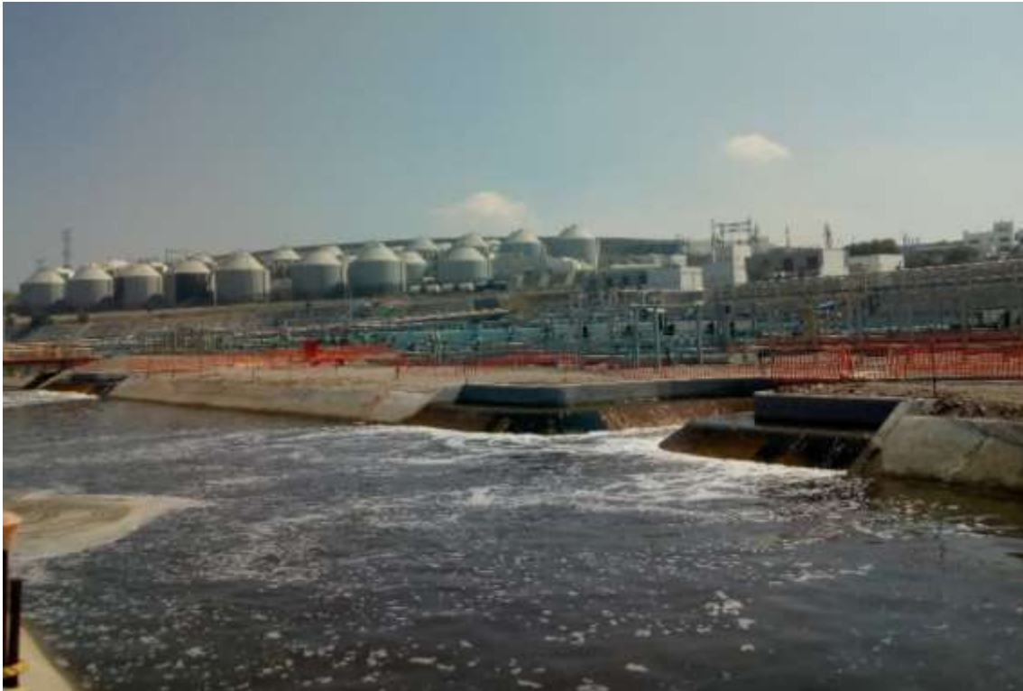
Figura 41. Digestores anaerobios desde el canal de entrada
