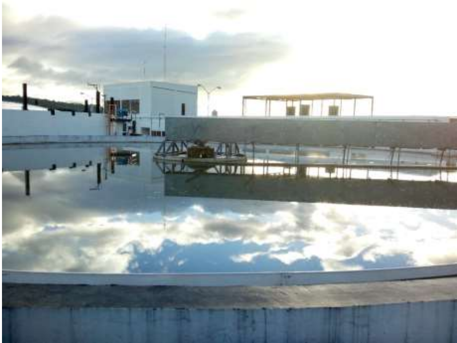
Figura 28. Sedimentador primario
