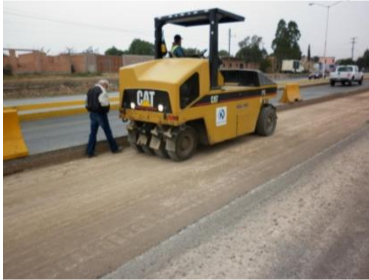
Ilustración 31 Una vez que se freso la carpeta y la base, se hace circular un compactador neumático con el objetivo de detectar hundimientos en la estructura.
