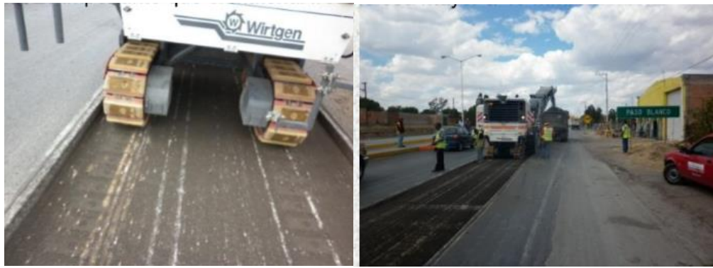
Ilustración 29 Fresado de los materiales.
