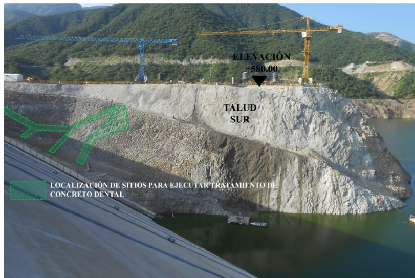
Figura 46. Proyección de sitios donde se ejecutaron tratamientos de concreto dental, vista lateral del Talud Sur del espolón de roca, (CFE, septiembre 2014).
