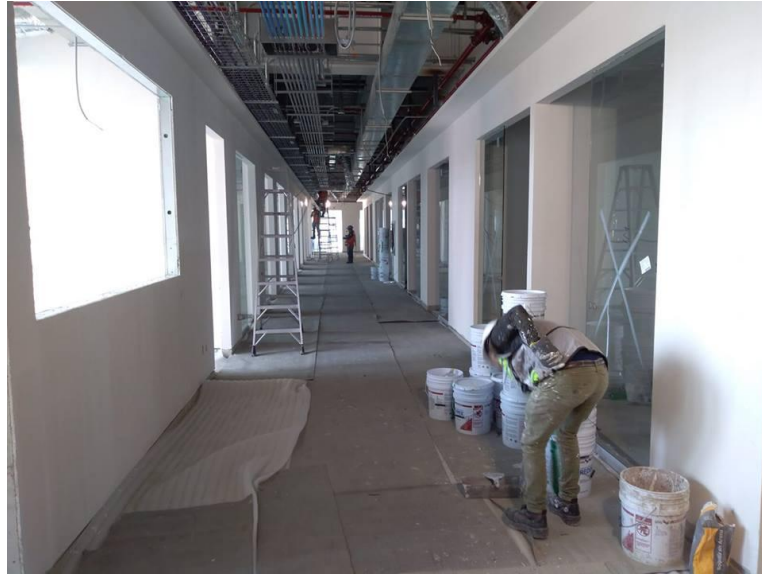
Imagen 34. Colocación de primera mano de pintura en pasillo
