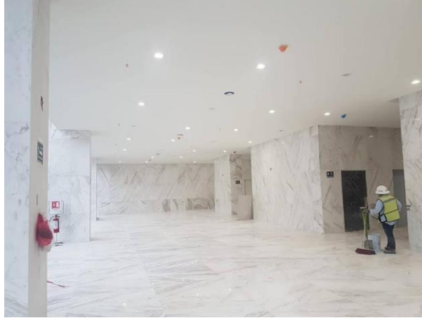
Imagen 36. Vista de área con colocación de mármol terminada
