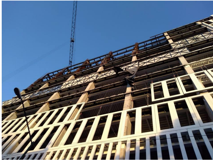
Imagen 9. Fachada Escuela de Jueces. Colocación de Louvers
