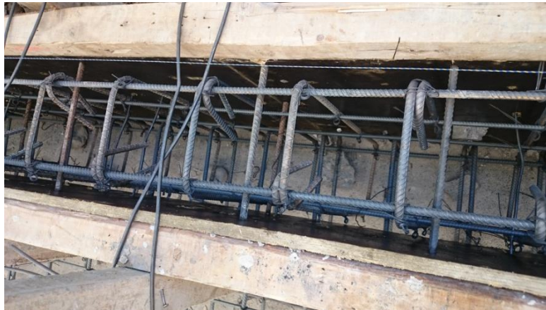
Imagen 10. Cadena de desplante de muro
