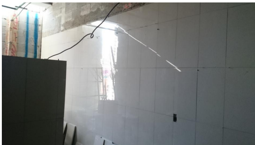
Imagen 32. Porcelanato en muros de baño
