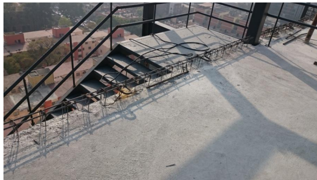
Imagen 19. Chaflán en azotea
