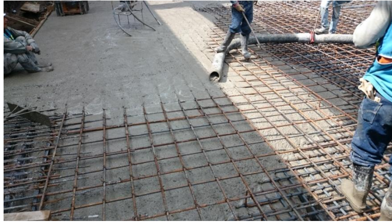
Imagen 18. Colado de piso
