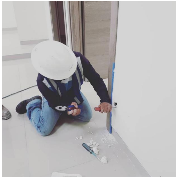
Imagen 7. Ejemplo de bitácora fotográfica de trabajos realizados sobre un muro terminado.
