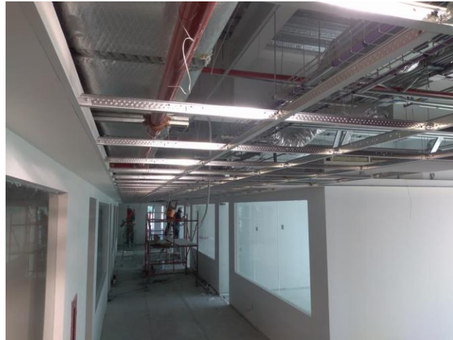
Imagen 27. Sistema de cielo corrido
