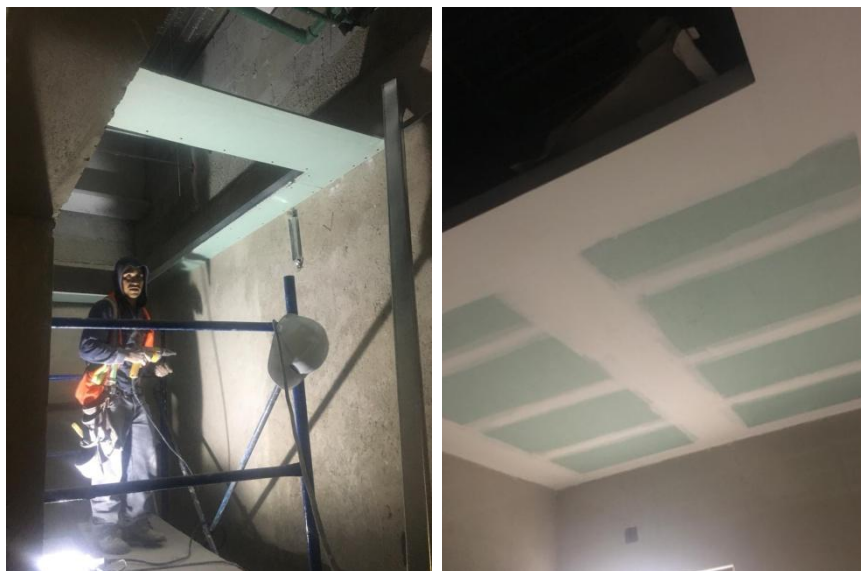
Imagen 26. Colocación de platabanda
