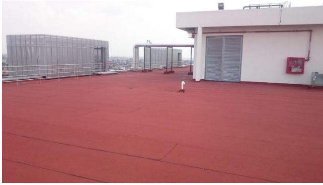
Imagen 22. Vista de impermeabilizante en azotea
