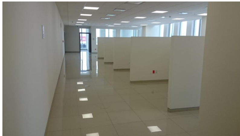
Imagen 37. Vista de área con colocación de segunda mano de pintura
