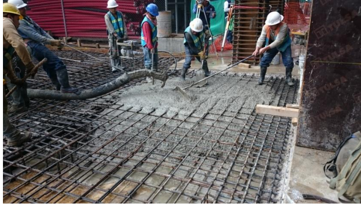
Imagen 16. Bomba vaciando concreto.
