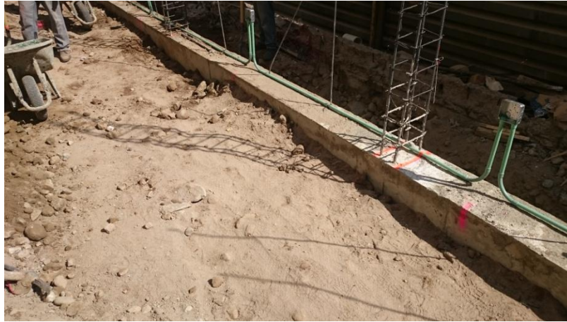
Imagen 11. Cadena de desplante colada con castillos ahogados e instalaciones
