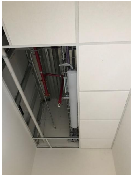
Imagen 29. Colocación de galletas sin platabanda
