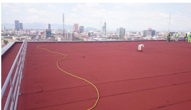
Imagen 21. Vista de impermeabilizante en azotea
