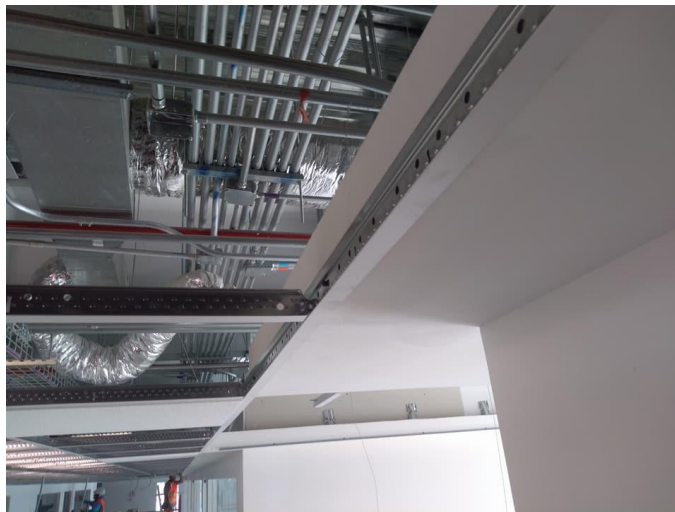
Imagen 28. Sistema de cielo corrido
