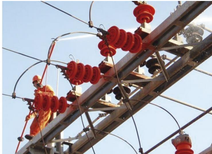
Figura 3.11 Aisladores con recubrimiento elastomérico
