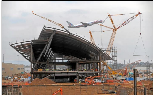
(Construcción de la Terminal 4 de Aeropuerto LAX, Los Angeles. Fuente: BDI)
