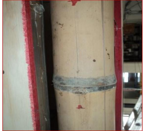
Figura 6.2 Fotografía que muestra fisuras verticales en una columna de bambú en el primer nivel.
