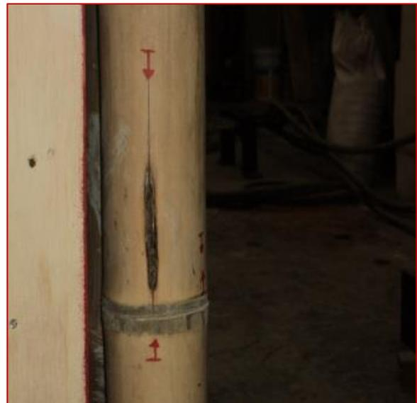
Figura 6.4 Fotografía que muestra fisuras verticales en una columna de bambú en planta baja.
