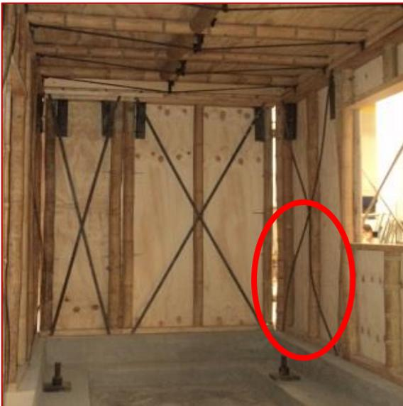
Figura 6.3 Fotografía que muestra la parte interna de la planta baja de la casa. En el óvalo rojo se observa la deformación de los contravientos en el interior de la estructura.
