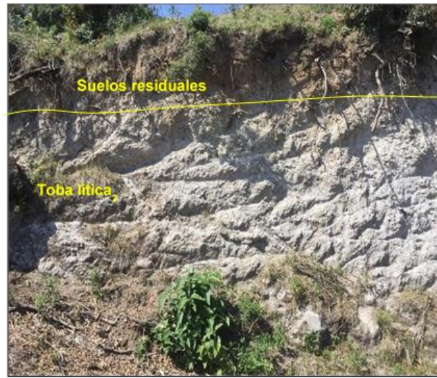
Fotografía 4.27. Suelo residual en el área del talud.
