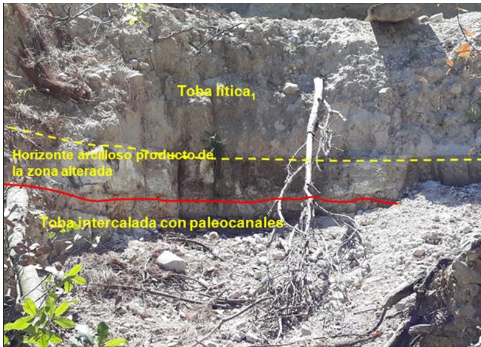
. Fotografía 4.35. Horizonte erosivo (en rojo) de la Toba intercalada con paleocanales, en contacto con el horizonte alterado de la Toba lítica 1 .
