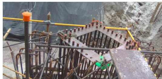
Ilustración 121 Conexión con la estructura de la torre. 7
