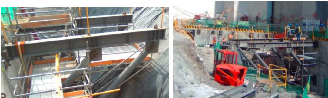
Ilustración 136 Montaje de estructura de la plataforma A y B. 7
