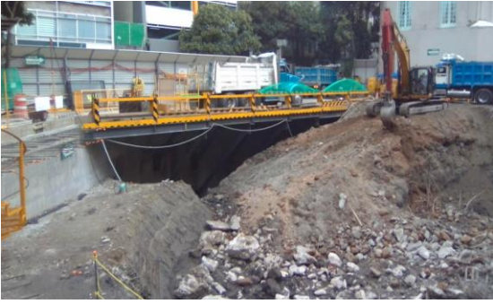
Ilustración 141 Rampa de acceso a la excavación del núcleo. 7
