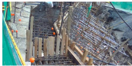
Ilustración 126 Límites de la sección en donde se hará el vaciado del concreto. 7
