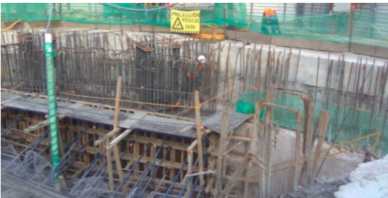
Ilustración 122 Colocación de cimbra. 7
