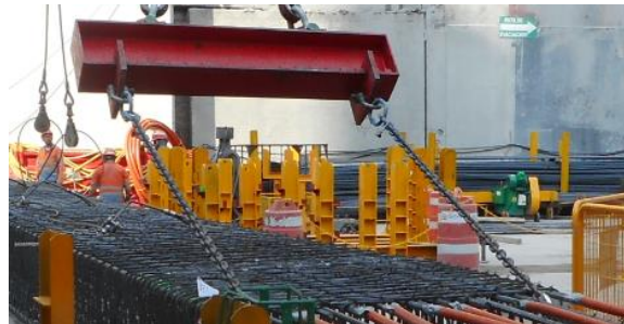
Ilustración 87 Izado. Uso del balancín. 7
