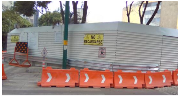
Ilustración 56 Paso de transeúntes en el cruce de Viena y Lucerna. 7
