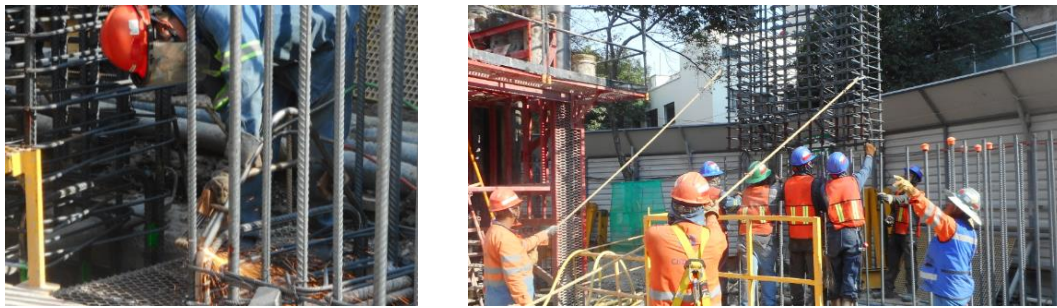
Ilustración 90 Unión de dos jaulas. 7
