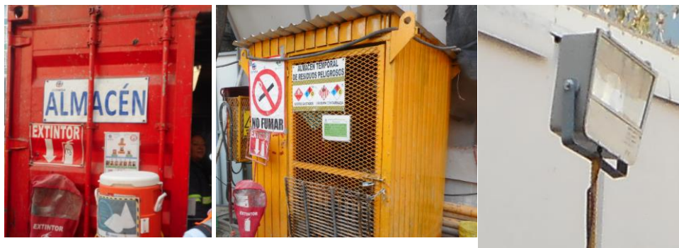
Ilustración 59 Almacén de la obra e instalaciones. 7
