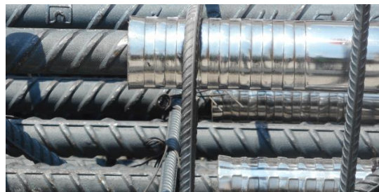
Ilustración 84 Conectores de aluminio. 7
