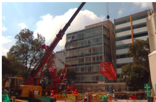
Ilustración 139 Montaje de la pluma de la grúa. 7
