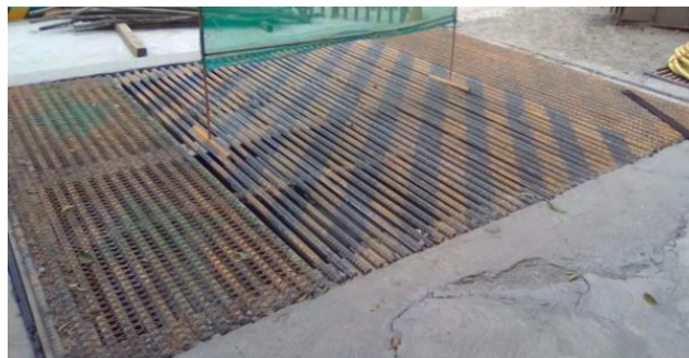
Ilustración 154 Rejillas en los accesos. 7
