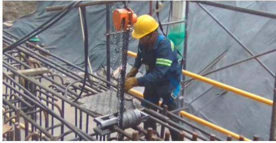
Ilustración 112 Unión de varillas. 7
