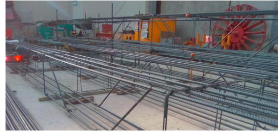
Ilustración 103 Extensiones de acero de refuerzo del barrete. 7
