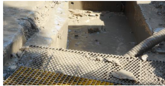
Ilustración 68 Suministro de lodos bentoníticos a zanjas. 7
