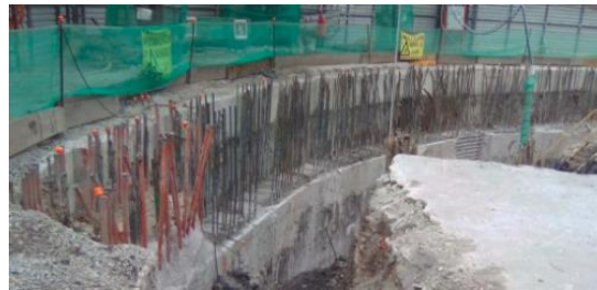
Ilustración 109 Acabado final de la lumbrera, después del descabezado. 7
