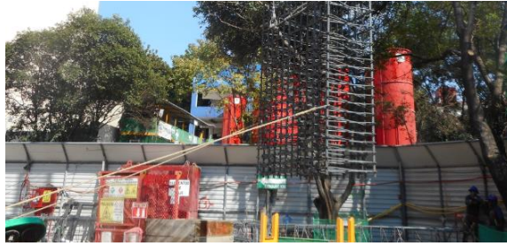
Ilustración 88 Izaje de la jaula sobre la zanja. 7
