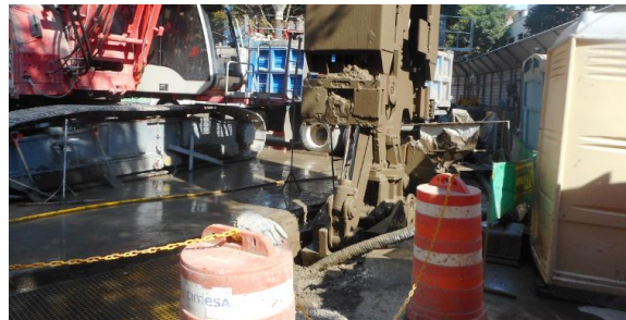
Ilustración 67 Excavación de panel con almeja hidráulica semiguiada. 7
