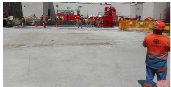
Ilustración 55 Sitio de construcción en proceso. 7
