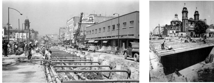
Ilustración 13 Construcción del metro en las Ciudad de México. 21
