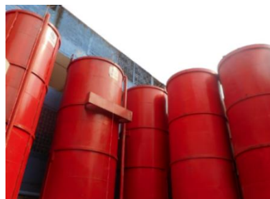
Ilustración 37 Silos de lodos bentoníticos. 7
