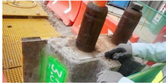
Ilustración 72 Junta CWS adherida al concreto. 7
