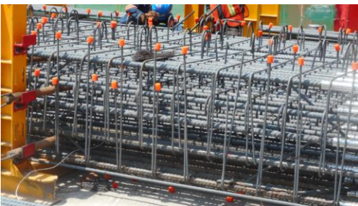
Ilustración 83 Almacén de jaulas de acero reforzado. 7
