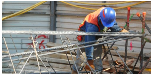
Ilustración 82 Colocación de estribos en jaulas de acero reforzado. 7
