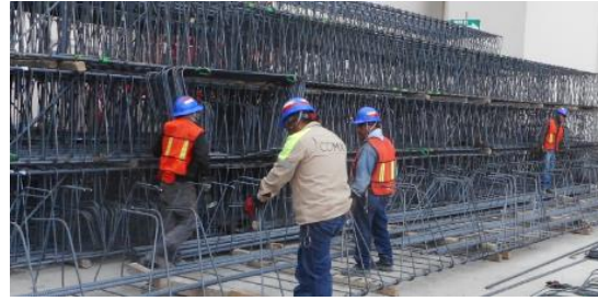
Ilustración 80 Producción de jaulas. 7
