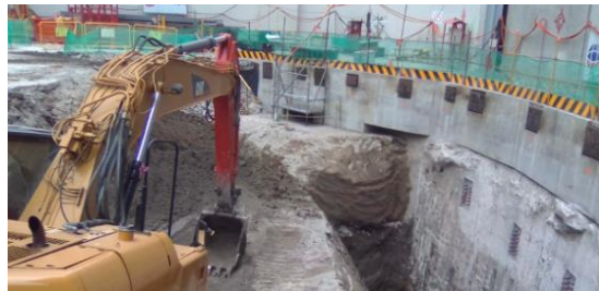
Ilustración 133 Colocación de placas en la trabe de coronamiento. 7
