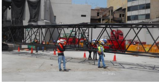
Ilustración 153 Mantenimiento a la grúa. 7
