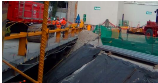
Ilustración 138 Aspecto final de la plataforma. 7
