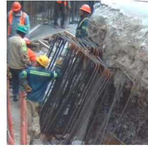
Ilustración 113 Estribos antes de ser colocados. 7
