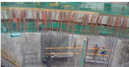
Ilustración 118 Preparación para empotramiento de ménsulas. 7
