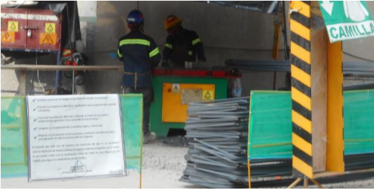
Ilustración 79 Habilitado de acero. 7
