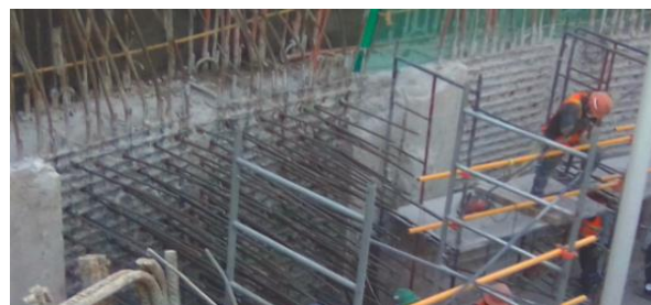
Ilustración 119 Anclaje para ménsula. 7
