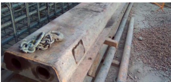
Ilustración 100 Juntas CWS, sin banda de neopreno. 7
