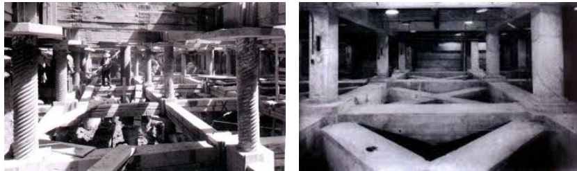
Ilustración 26 Vista de sótanos de la Torre Latinoamericana. Durante y después de su construcción. 35
