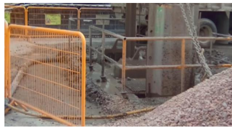
Ilustración 99 Excavación de barrettes centrales. 7
