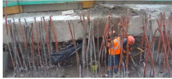
Ilustración 108 Realización del acabado final. 7
