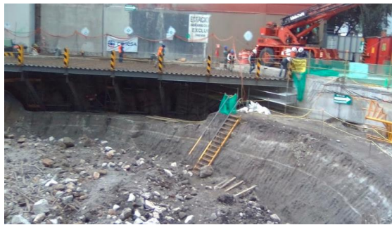
Ilustración 144 Aspecto general de la excavación. 7
