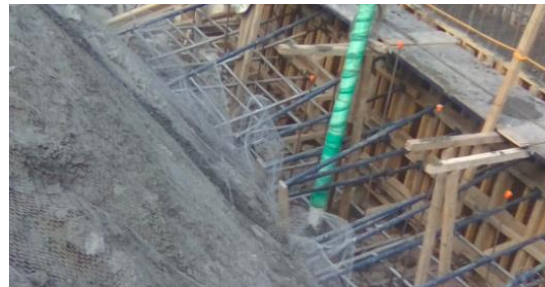
Ilustración 123 Apuntalamiento de la cimbra en la excavación. 7
