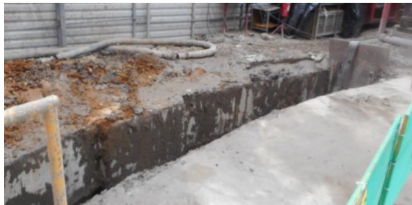
Ilustración 62 Vista de zanja, previo a la colocación de acero de refuerzo. 7
