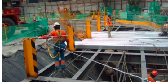
Ilustración 137 Colocación de losa acero. 7
