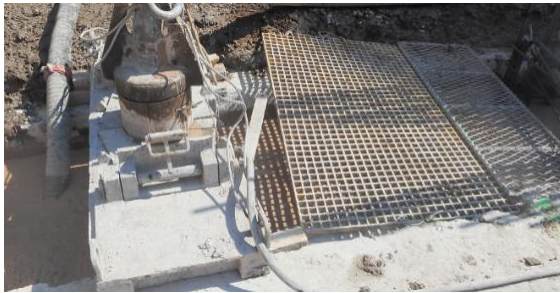
Ilustración 68 Suministro de lodos bentoníticos a zanjas. 7
