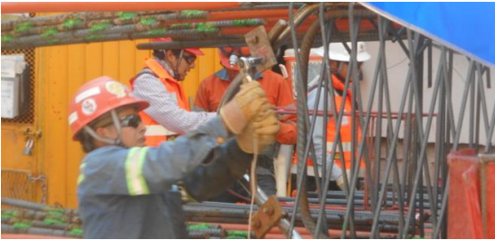
Ilustración 85 Colocación de asas para izaje. 7
