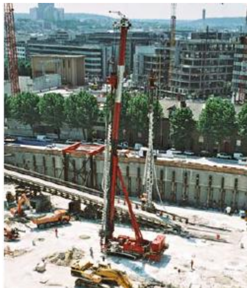
Ilustración 8 Instalación de pilotes. 15
