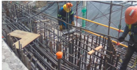
Ilustración 120 Colocación de acero longitudinal. 7
