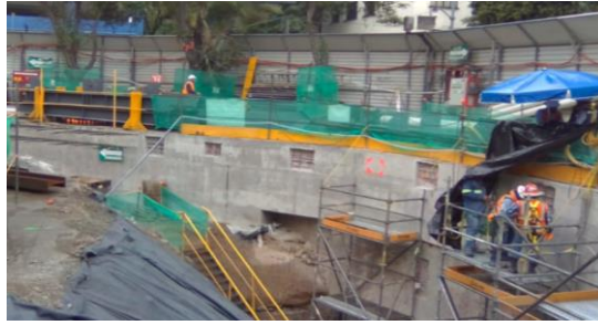
Ilustración 132 Construcción de plataforma. Preparaciones en la lumbrera. 7
