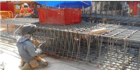
Ilustración 81 Desarrollo de trabajos de soldadura en jaulas de acero reforzado. 7
