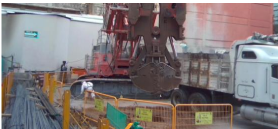
Ilustración 98 Excavación de barrettes radiales. 7
