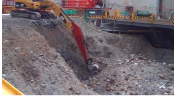
Ilustración 142 Excavación del núcleo desde la superficie. 7
