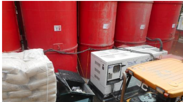
Ilustración 58 Silos donde se almacenan lodos bentoníticos en el predio adyacente . 7
