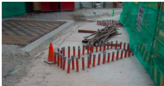
Ilustración 129 Aspecto de las preparaciones para las uniones con la estructura, después del colado. 7
