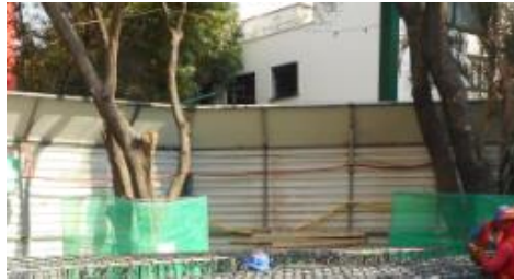
Ilustración 2 Protección a árboles ya existentes en la obra. 7
