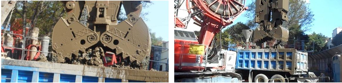
Ilustración 63 Almeja semiguada usada para excavar paneles. 7
