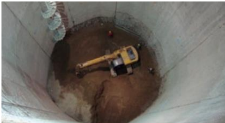
Ilustración 20 Excavación del núcleo de lumbrera. 29
