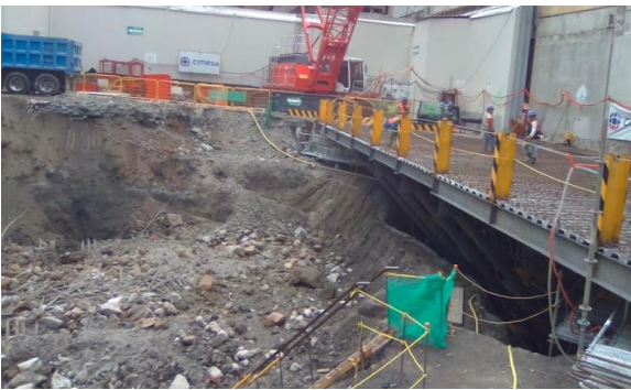
Ilustración 143 Vista de plataforma. 7
