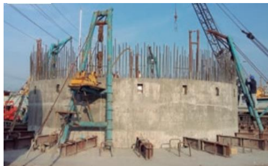
Ilustración 18 Construcción de Lumbrera por flotación. 29
