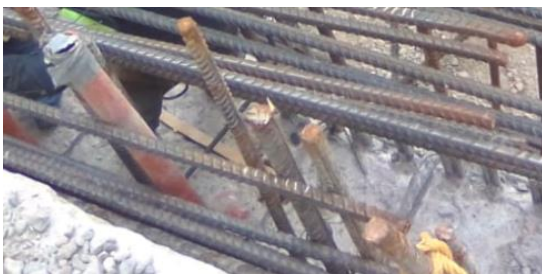
Ilustración 114 Colocación de juntas debajo del acero de refuerzo. 7
