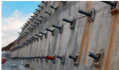
Ilustración 14 Sistemas de anclaje. 25
