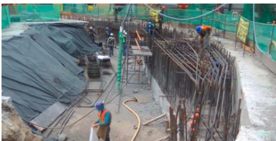
Ilustración 125 Acero de refuerzo en la ménsula y en la trabe de coronamiento. 7
