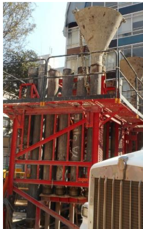
Ilustración 92 Depósitos de segmentos del Sistema Tremie. 7
