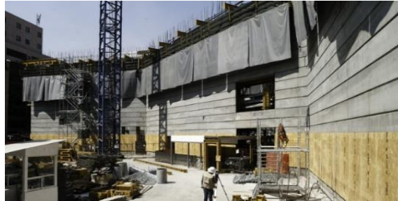
Ilustración 30 Cimentación de la Torre Reforma. 40
