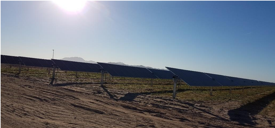
Vista del parque fotovoltaico
