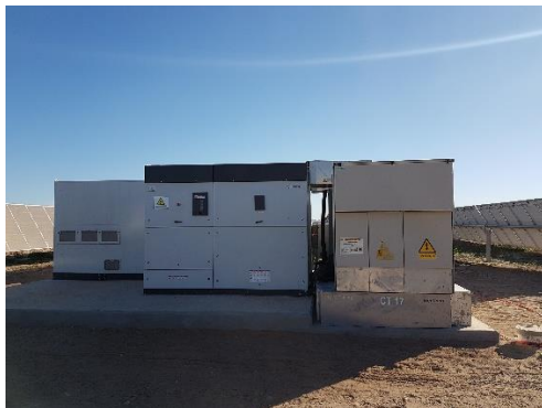
Vista frontal de centro de transformación / Acometida en inversores de cajas combinadoras
