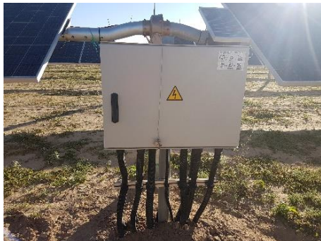
Vista frontal de caja combinadora recibe cadenas en corriente directa
