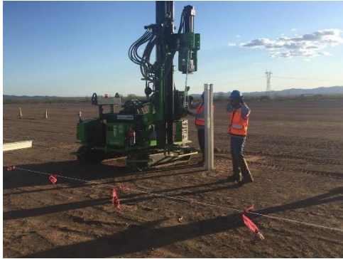
Inicio de obras: hincado y zanjado
