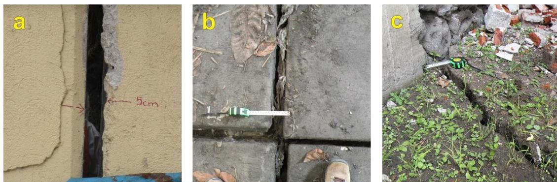
**Figura 5.8.** Fotografías de grietas de 7 a 8 cm de extensión, la cuales coinciden con la diferencia de desplazamientos observada en el mapa de subsidencia de la Figura 5.7.
