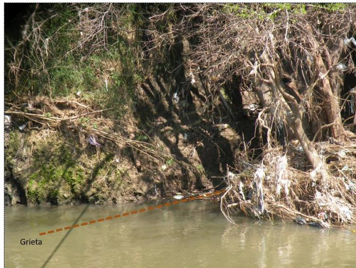
**Figura 6.4.** Fotografía al Norte del río Apatlaco donde una grieta de  $\pm 1$  m de desplazamiento vertical, produce el colapso local de un bloque hacia el río.
