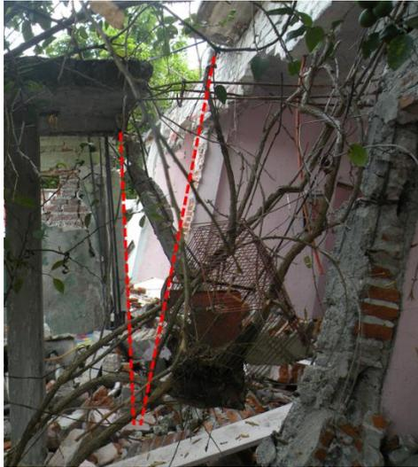
**Figura 6.1.** Fotografía donde se observa la inclinación de la estructura parcialmente colapsada al sur de la colonia Lázaro Cárdenas, lo cual pudo haber sido causado por licuefacción.
