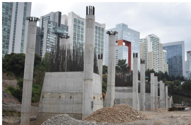
Figura IV-10 Columnas principales para la estación Santa Fe. 66
