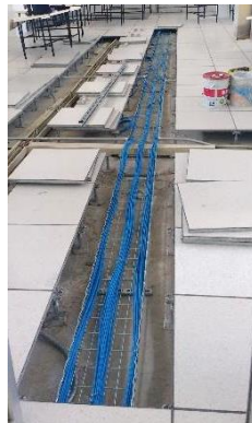
Figura 1-10 Instalación de cable Cat 6A (propia)
