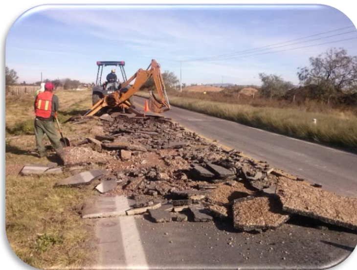
Ilustración 25: Demolición de la carpeta dañada. (MMG, 2019)
