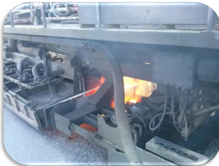
Ilustración 32: Escarificadores en la recicladora. (MMG, 2019)
