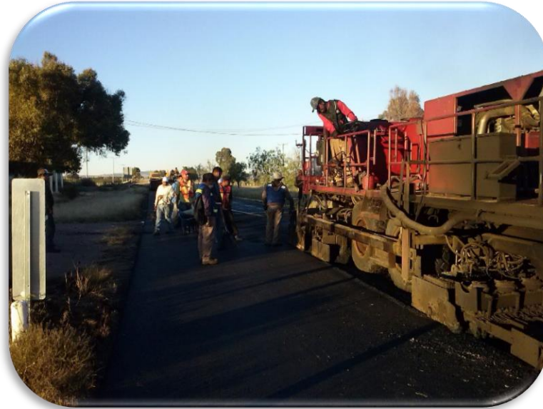
Ilustración 37: Máquina recicladora ejecutando el segundo carril. (MMG, 2019)
