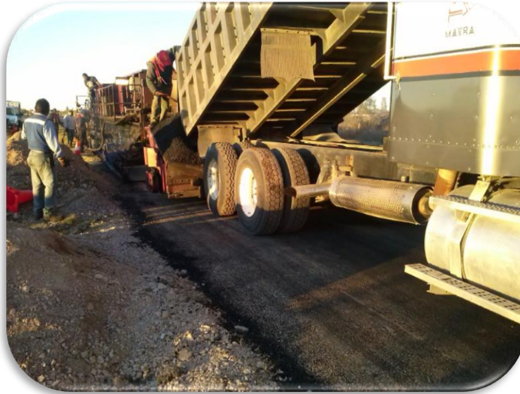
Ilustración 35: Descarga de la mezcla asfáltica de planta hacia la maquina recicladora. (MMG, 2019)
