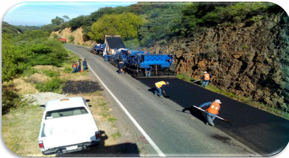
Ilustración 21: Maquinaria trabajando el reciclado de asfalto en caliente en un solo paso. (MMG, 2019)
