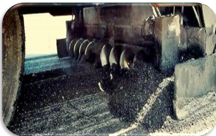
Ilustración 34: Rodillos sin fin, recuperando el reciclado. (MMG, 2019)
