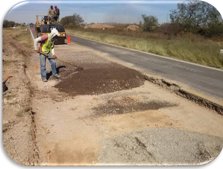
Ilustración 26: Colocación y compactación de la base hidráulica. (MMG, 2019)
