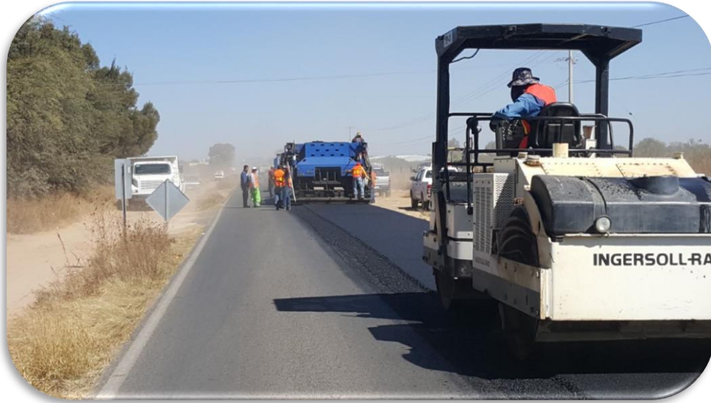
Ilustración 38: Proceso de compactación. (MMG, 2019)
