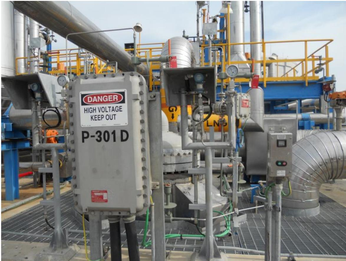
**Fotografía 13. Equipo a Prueba de Explosión Clase 1, División 1.**
