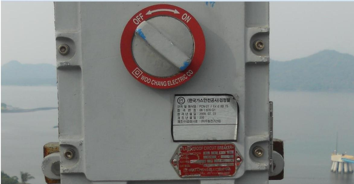
Fotografías 11 y 12. Interruptor eléctrico a prueba de explosión Clase I, División 1
