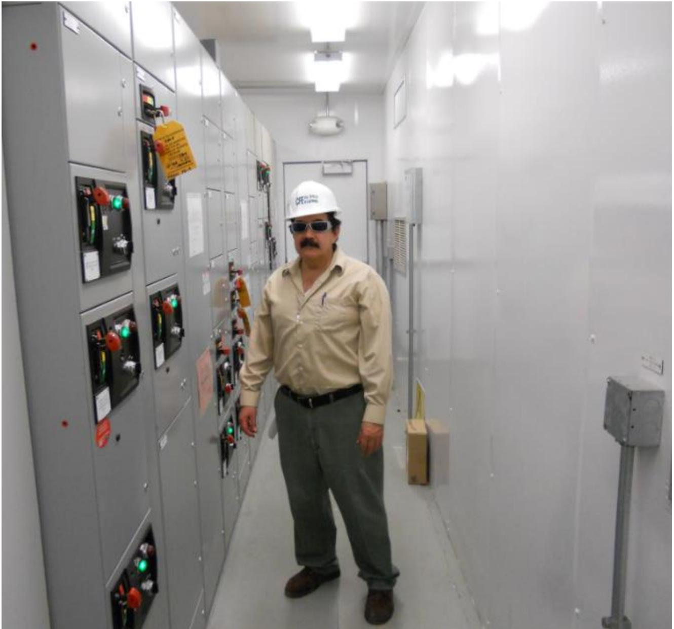
**Fotografía 22. Inspección contenedor de control de la Turbina de Gas Natural (GN) de la Repotenciación de Manzanillo I.**
