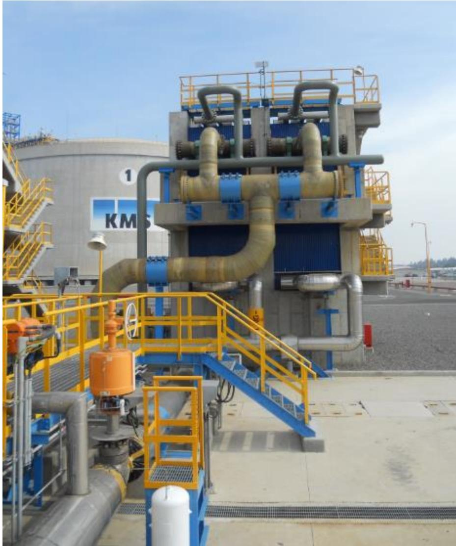
**Fotografía 2. Intercambiador de temperatura ORV**
