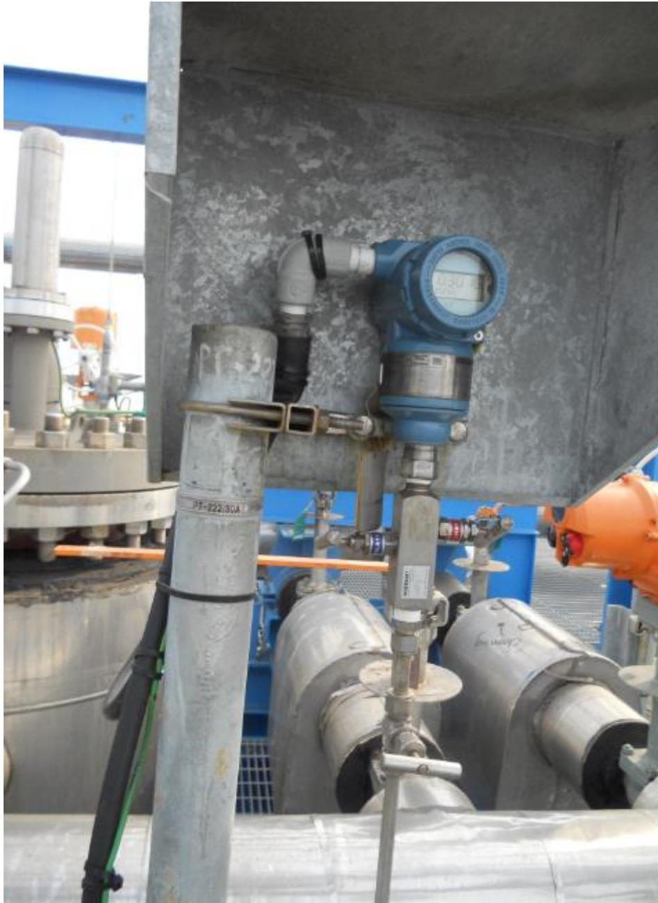
Fotografía 14. Transmisor de Presión en Domo Superior del Tanque de Almacenamiento.
