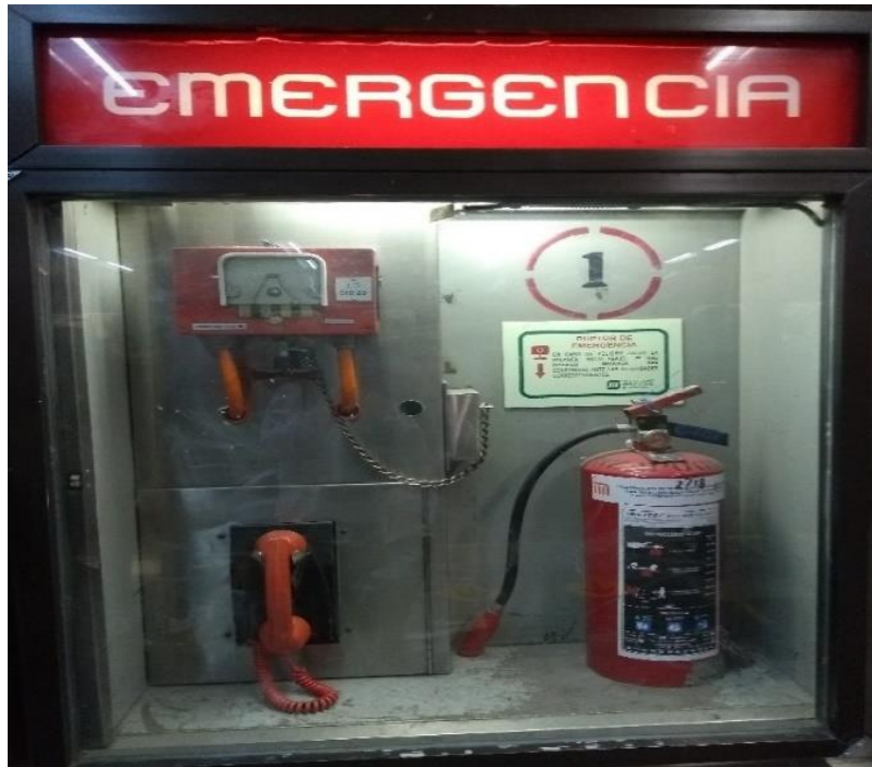
Figura 20. Botiquín de emergencia. Fuente: Foto tomada en la estación Zapata.
