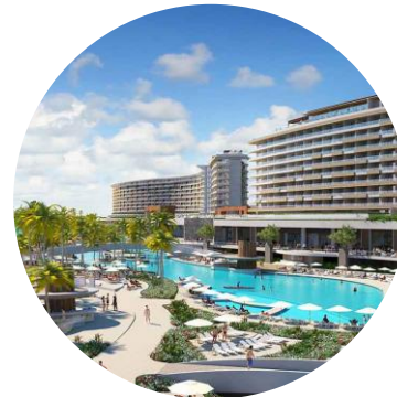
Hotel Hard Rock Riviera Cancún Gerencia de proyecto de construcción
