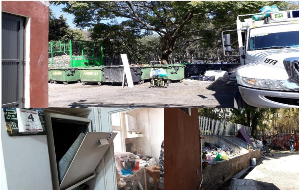
Figura 3.6 Ductos para la disposición de residuos dentro de los departamentos y el almacenamiento temporal.
