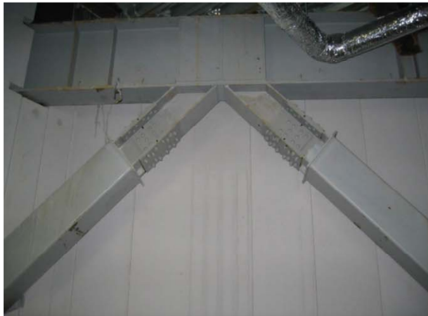
Figura 3.9: Contravientos de pandeo restringido (BRBs) [9] .
