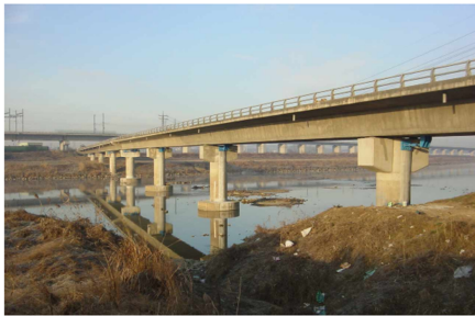
(a) Puente Dong-Yun, Corea del Sur
