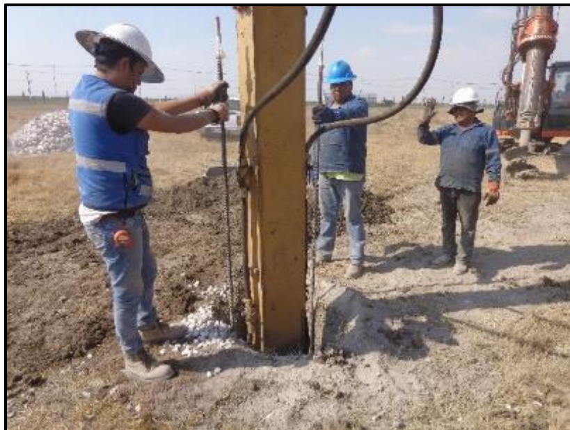
Figura 30.- Generación del bulbo
