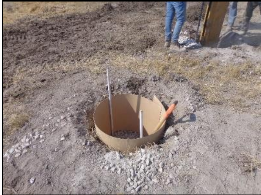
Figura 31.-Apisonamiento para general fuste del Geopier
