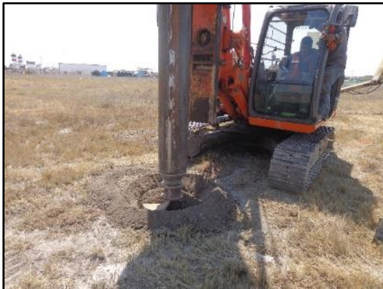
Figura 28.- Inicio de la perforación para los elementos Geopier
