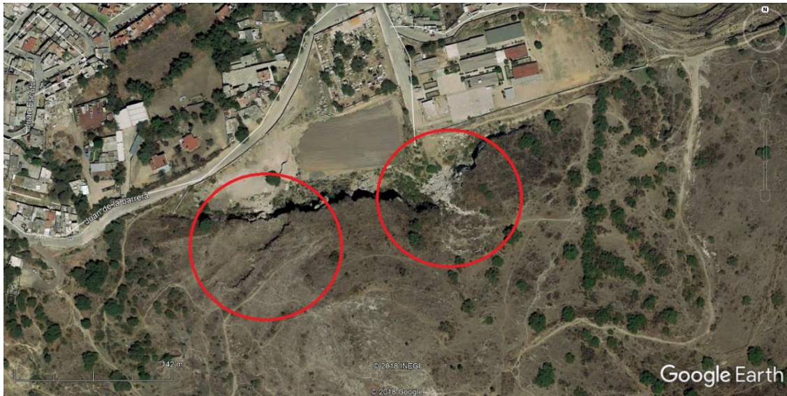
Foto 6. Imagen Satelital tomada de Google Earth de la Colonia Sta. María Cuauhtepéc. Círculo rojo del lado izquierdo, fractura de gran tamaño que pone en riesgo la integridad de la vía de comunicación. Círculo rojo del lado derecho un flujo de suelo como el mostrado en la figura 45c.
