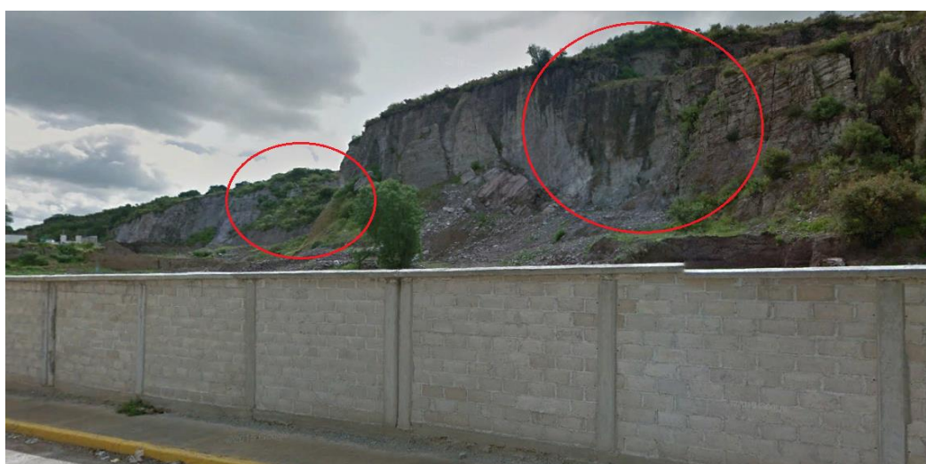
Foto 5. Calle Juan de la Barrera, Colonia Sta. María Cuauhtepc. En el círculo rojo del lado derecho, fractura en talud. Círculo rojo lado izquierdo, flujo de suelo cohesivo.
