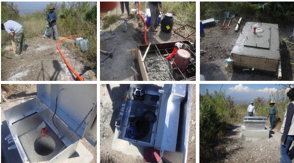
Figura 4.1 Ejemplo del proceso constructivo e instalación de una estación en lote baldío. En una secuencia de arriba abajo, de izquierda a derecha, se muestra el proceso de construcción de la estación E-11.
