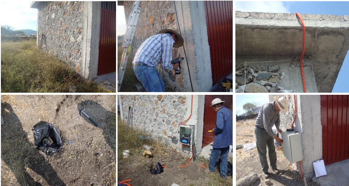
Figura 4.4 Proceso de instalación de una estación en un predio privado. Proceso de arriba a abajo de izquierda a derecha.
