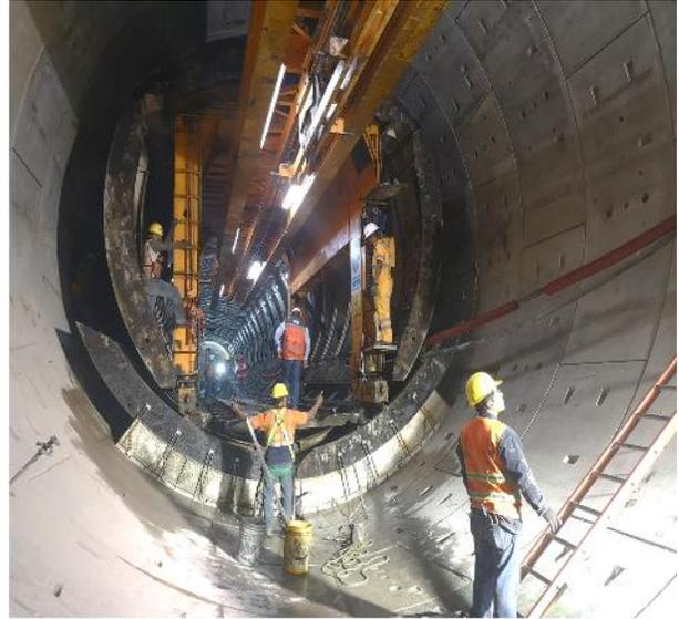
*Transportador diseñado para realizar las maniobras de movimiento e instalación de la cimbra telescópica, denominado "Jumbo". Fuente: ICA*
