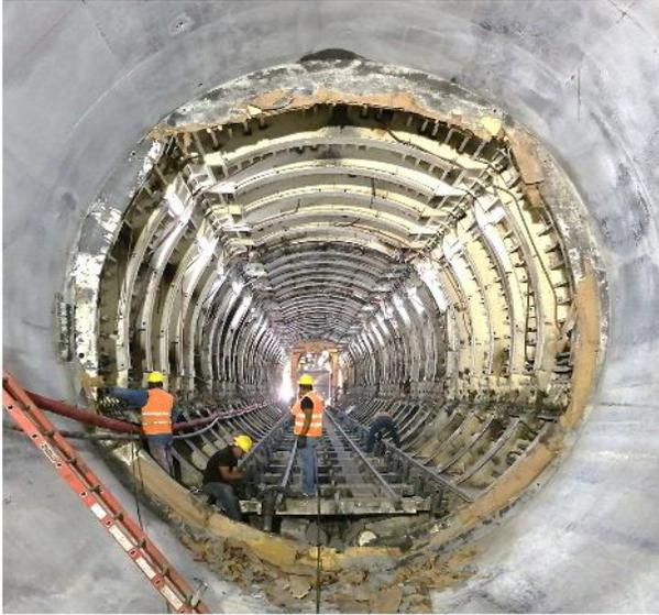
*Cimbra metálica telescópica. Revestimiento L19-L18.
