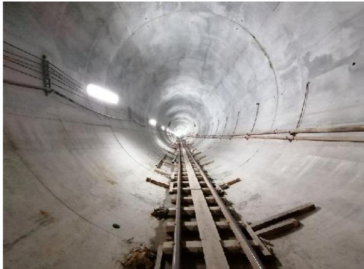
***Revestimiento definitivo del túnel a base de concreto reforzado. Fuente: ICA***
