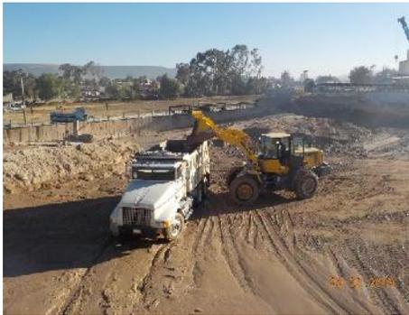
**Acarreo de material de excavación en L-19.**
