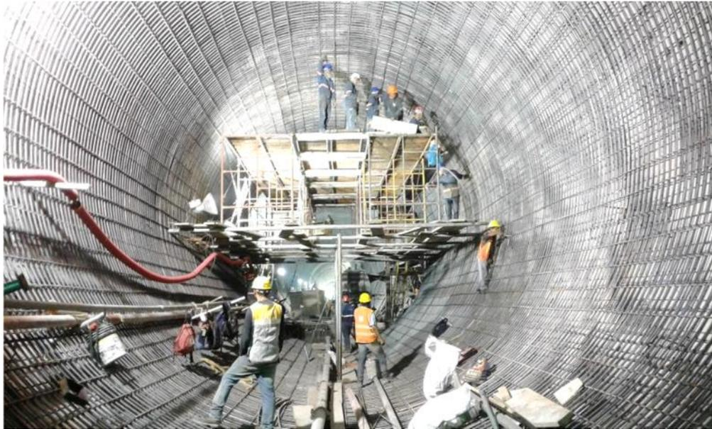
*Habilitado de acero de refuerzo del revestimiento definitivo del túnel. Fuente: ICA*
