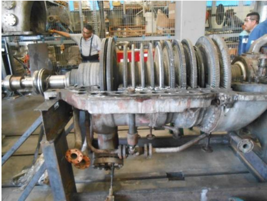
Figura 3.11 Turbina afectada, vista general.
