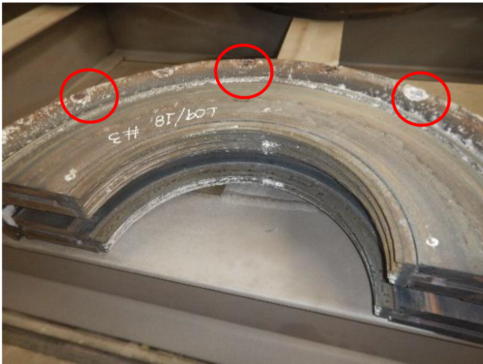
Figura 3.18 Diafragma dañado. Se presentan afectaciones de salinidad, dicha pieza se reemplazará en su totalidad.
