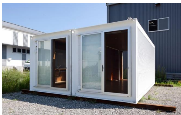
Figura 23. Vista del prototipo Ex Container terminado. (Design Boom, 2013)
