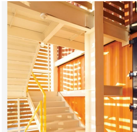
Figura 20. Vista de las escaleras muestra cómo se une la construcción tradicional con la construcción con contenedores. (Dwell, 2014)
