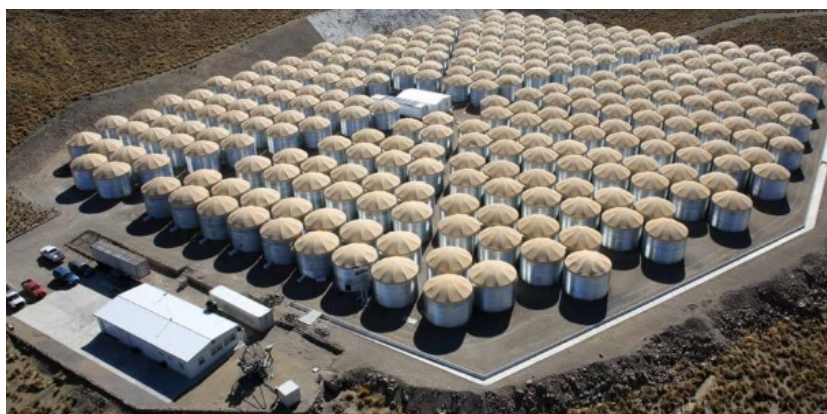
Figura 7.1: Los 300 tanques de HAWC.
