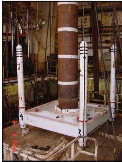
Figura. 3.5 Introducción del primer tramo de TR en el mud mat. (Ramírez, 2005).
