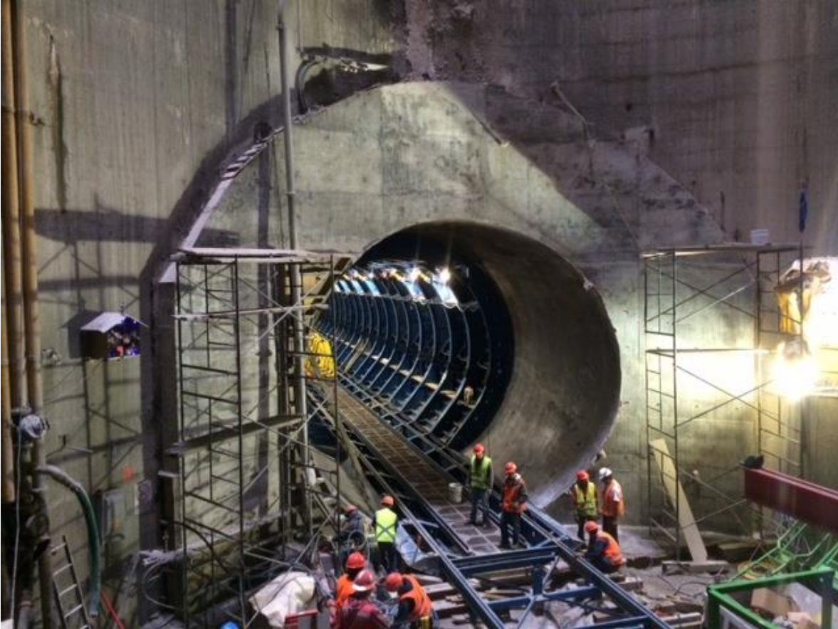
Figura 105. Emboquillado de portal de entrada a túnel.
