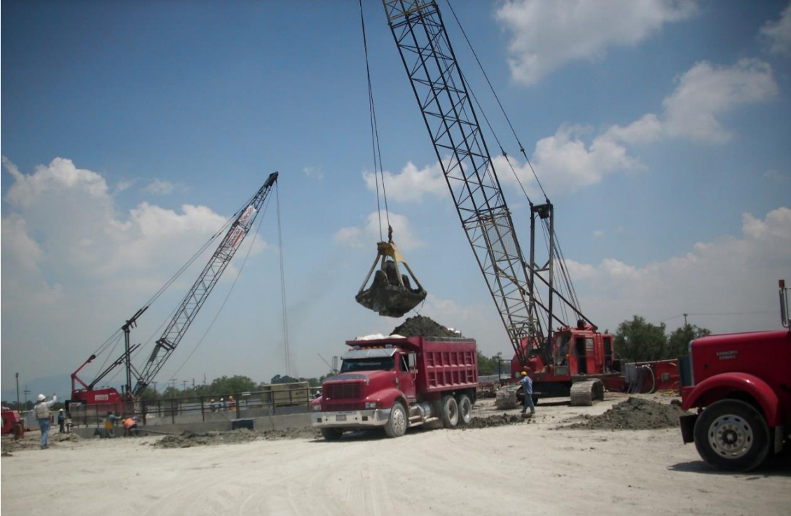
Figura 47. Acarreo de material producto de la excavación de núcleo de muro Millán con camión de carga.
