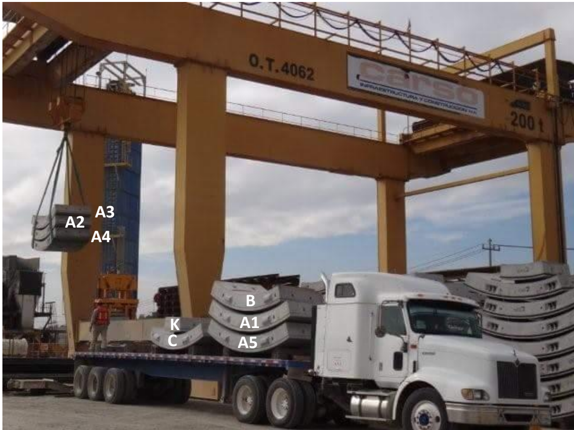
Figura 129. Ejemplo de transporte y descarga de dovelas en lumbrera.
