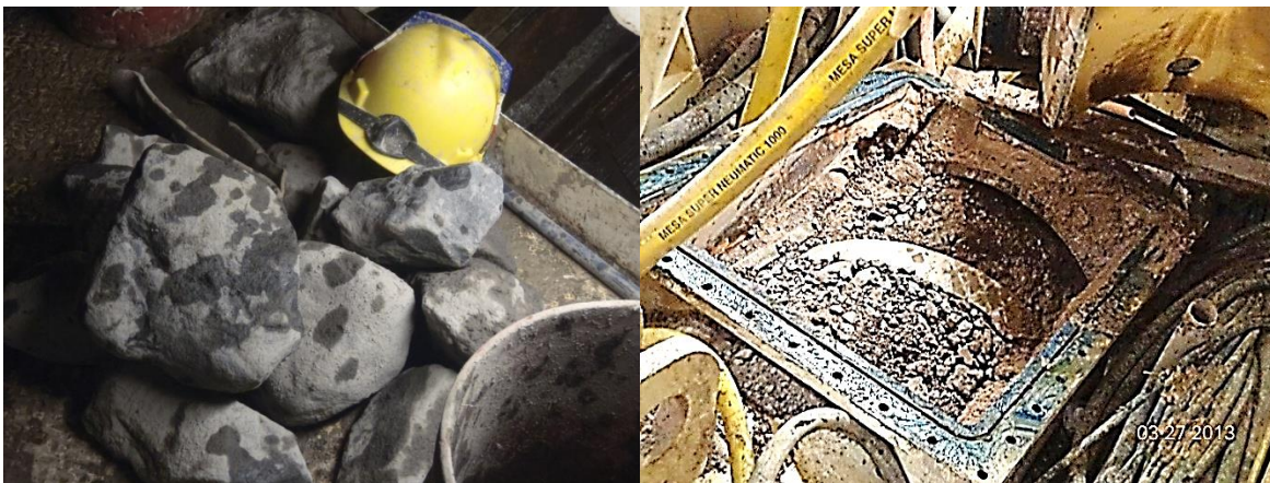
Figura 251. Boleos de roca y bloqueo del tornillo sin fin.
