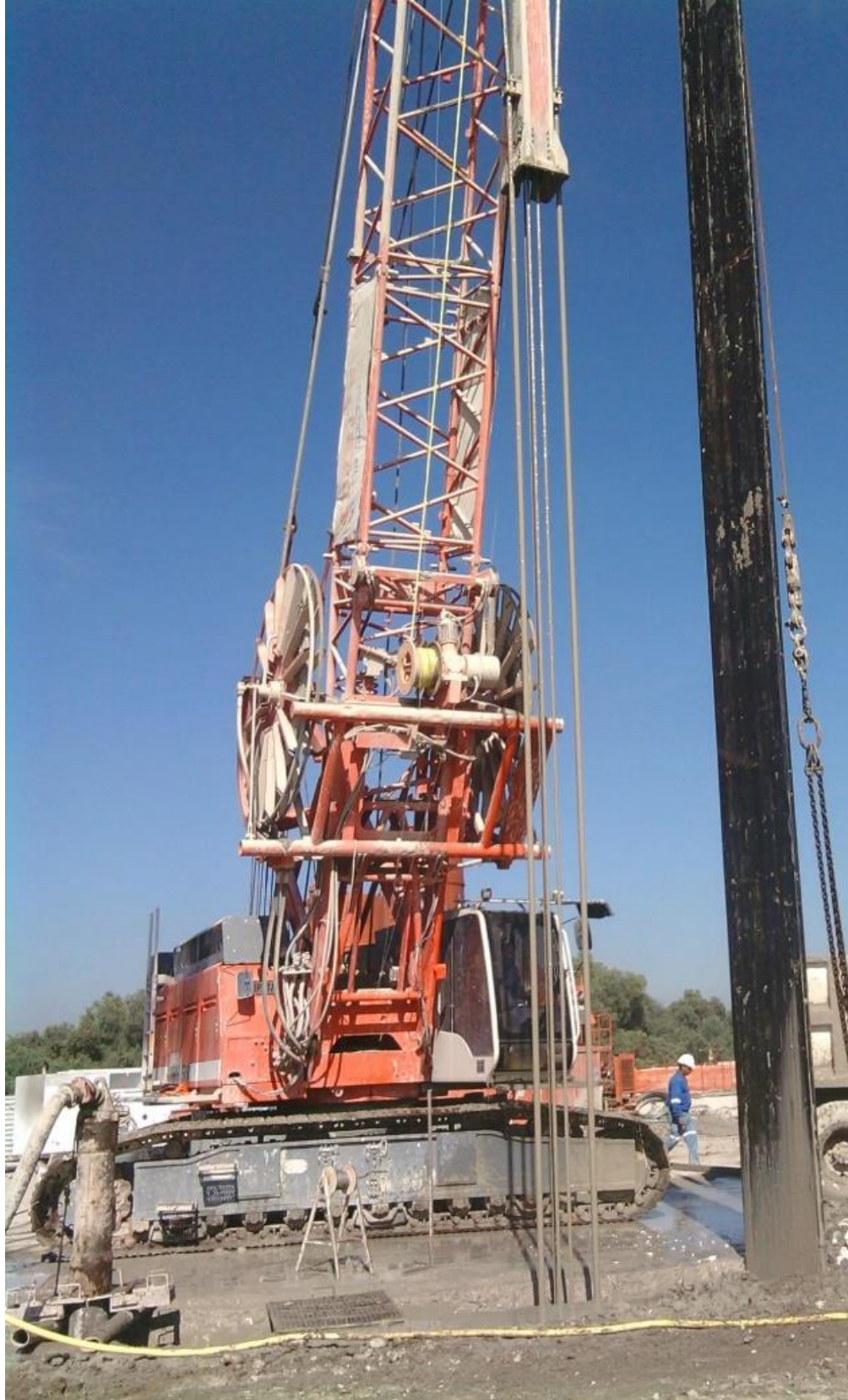
Figura 9. Hidrofresadora para excavación del muro Milán.
