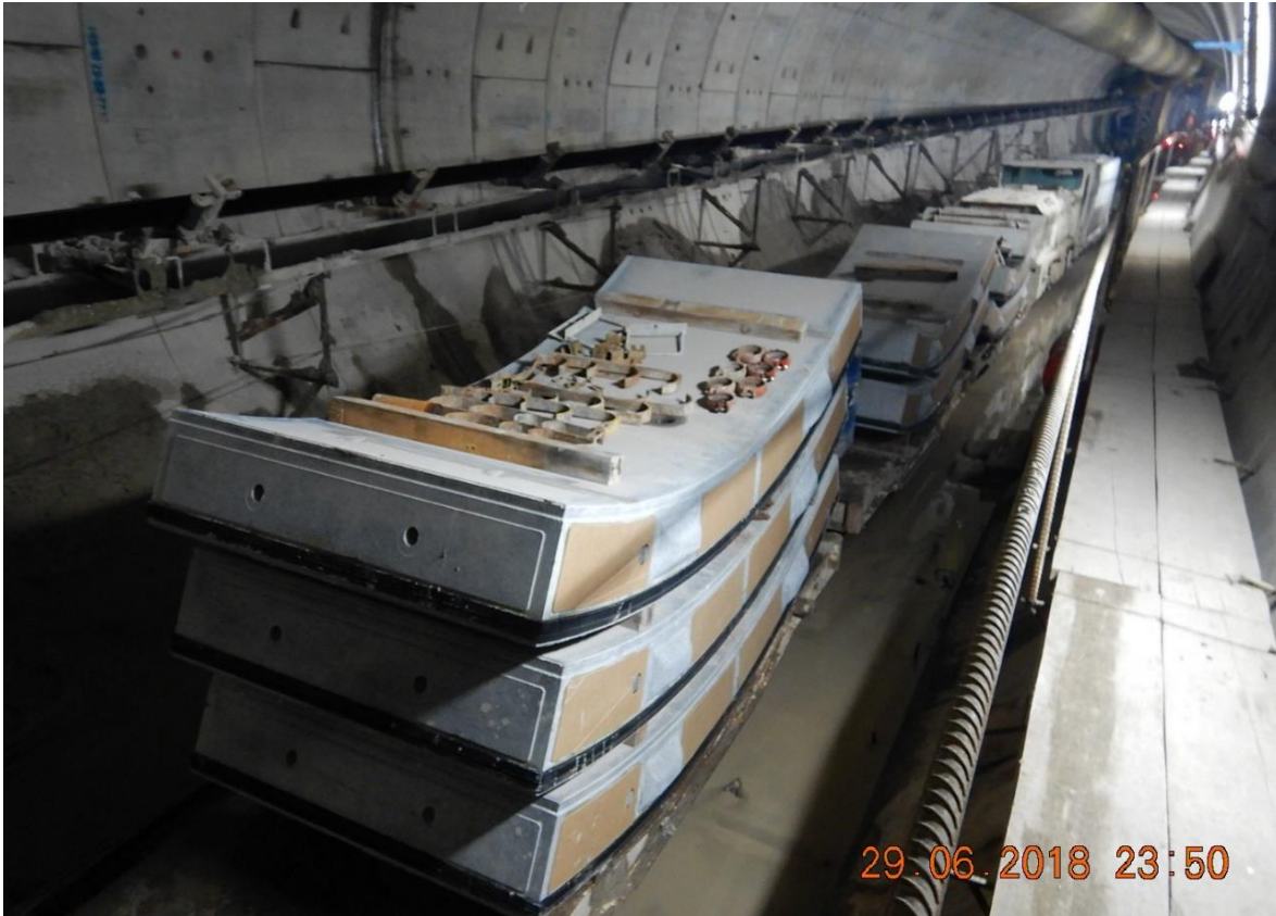
Figura 133. Acomodo de dovelas sobre los carros doveleros.
