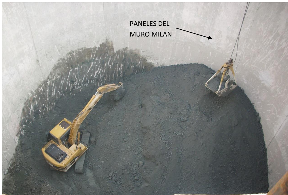
Figura 46. Excavación de núcleo central del muro Millán.
