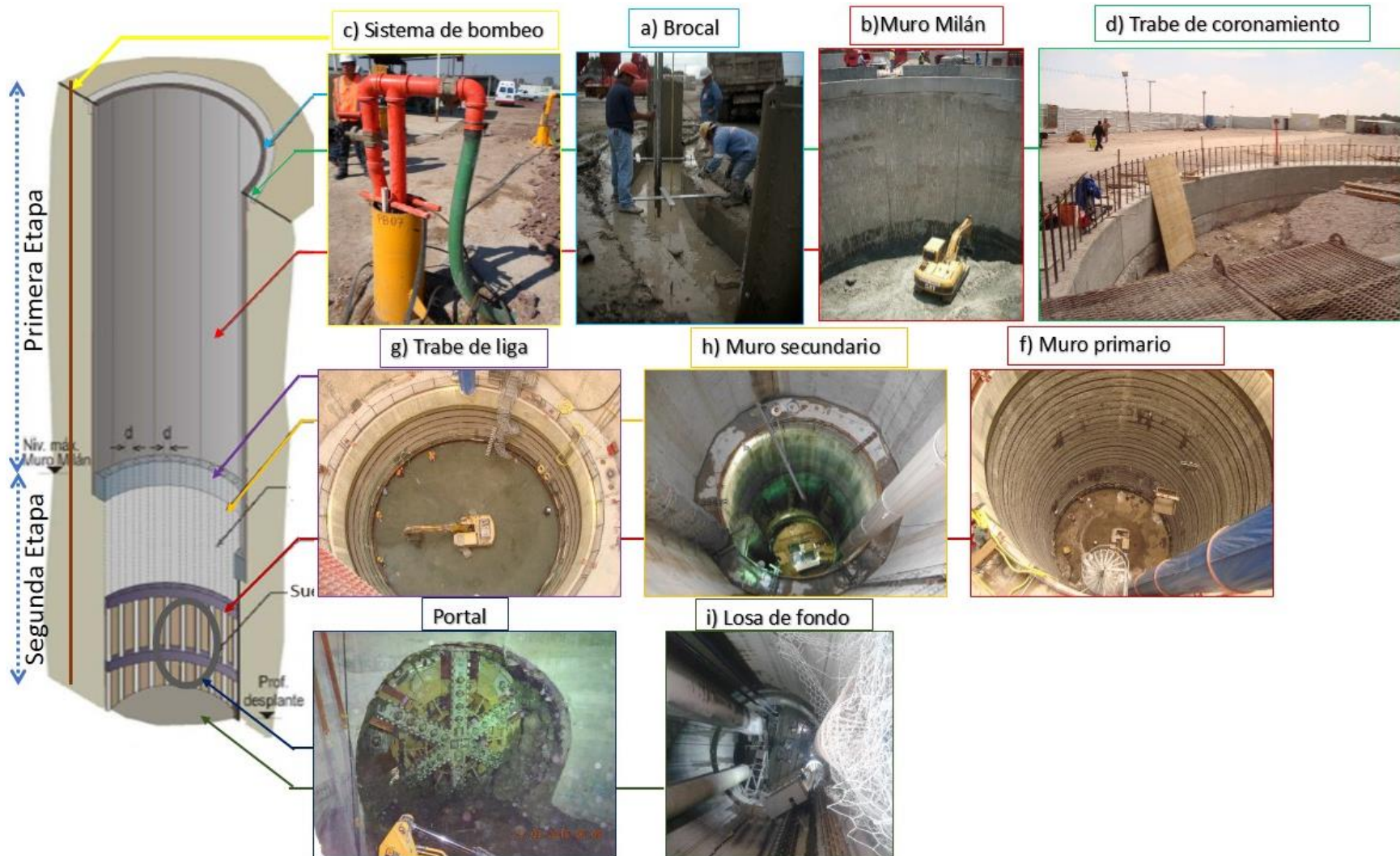
Figura 60. Características constructivas de las lumbreras del tramo 3.
