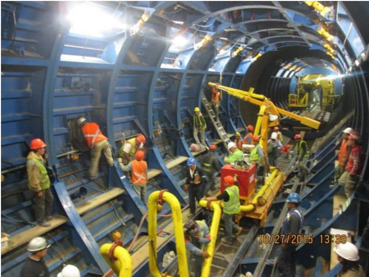
Figura 111. Snorkel retraible para inyección de concreto.
