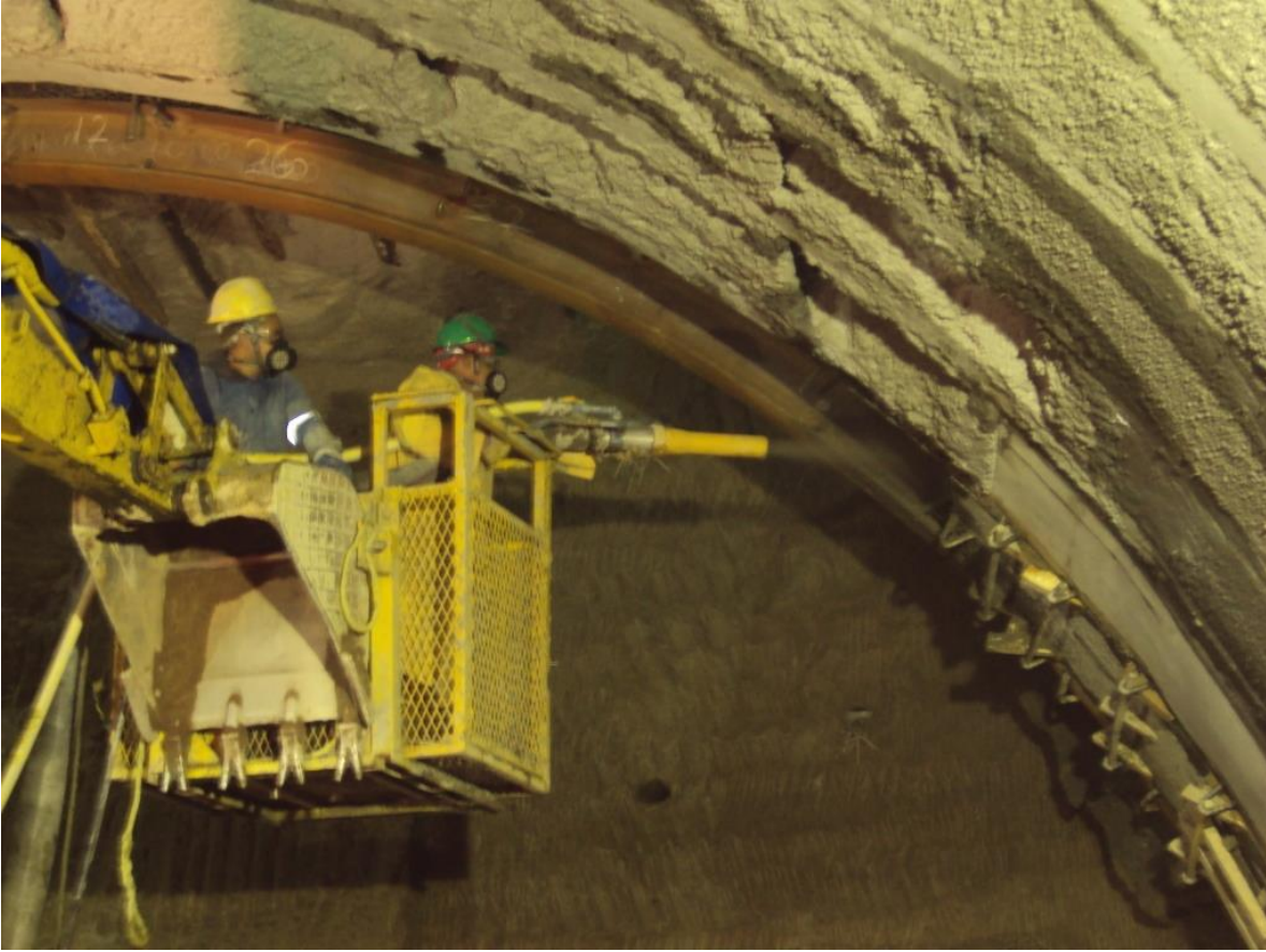
Figura 71. Colocación de concreto lanzado entre los marcos metálicos.
