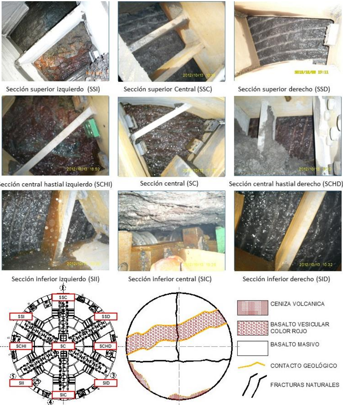
Figura 167. Conciliación del frente de excavación No. 9.
