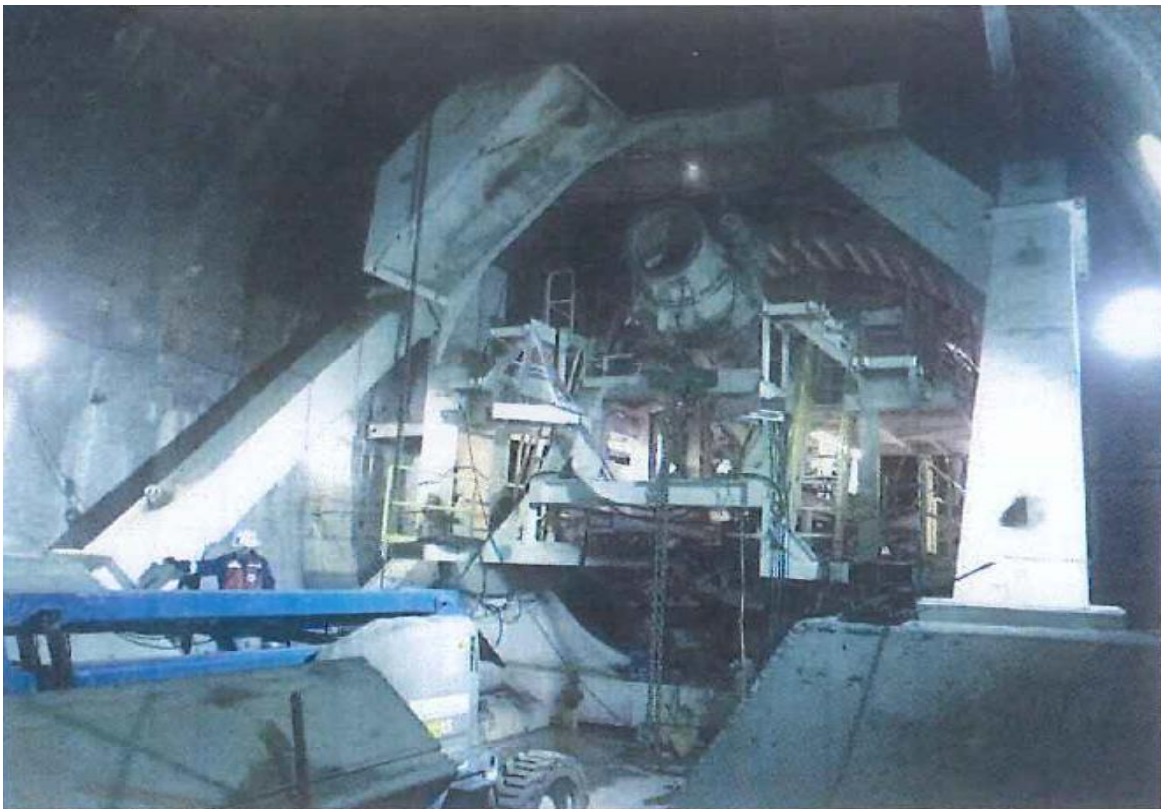
Figura 91. Instalación de la estructura de reacción y el anillo metálico.
