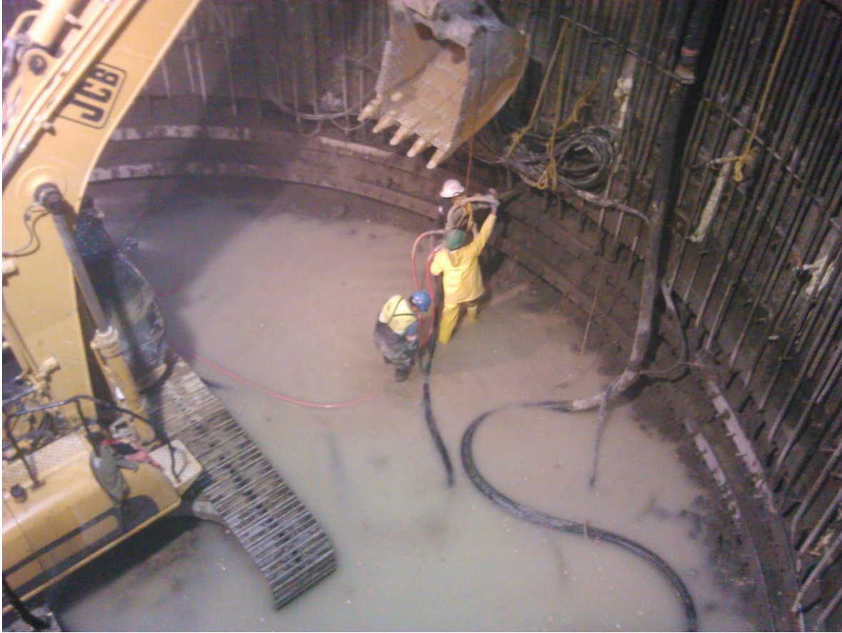
Figura 52. Concreto lanzado entre marcos metálicos.
