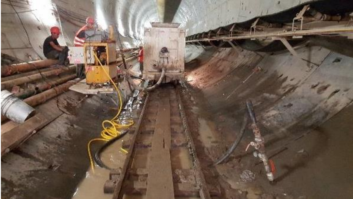
Figura 314. Reinyección en túnel.
