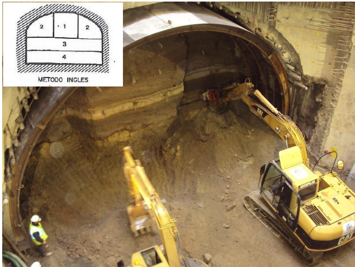
Figura 69. Secuencia de excavación de la galería.
