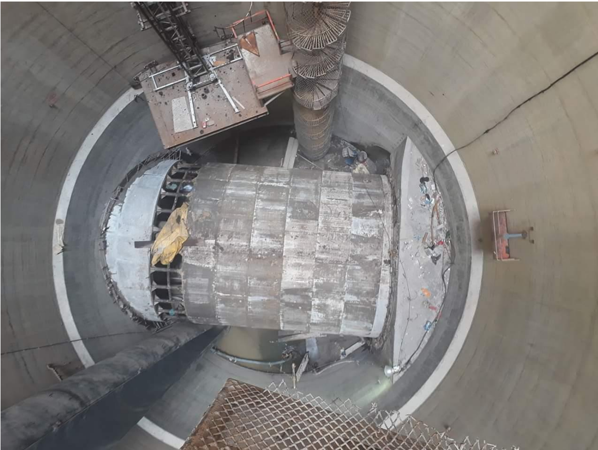
Figura 247. Estructuras para el paso de la tuneladora en lumbrera L12.
