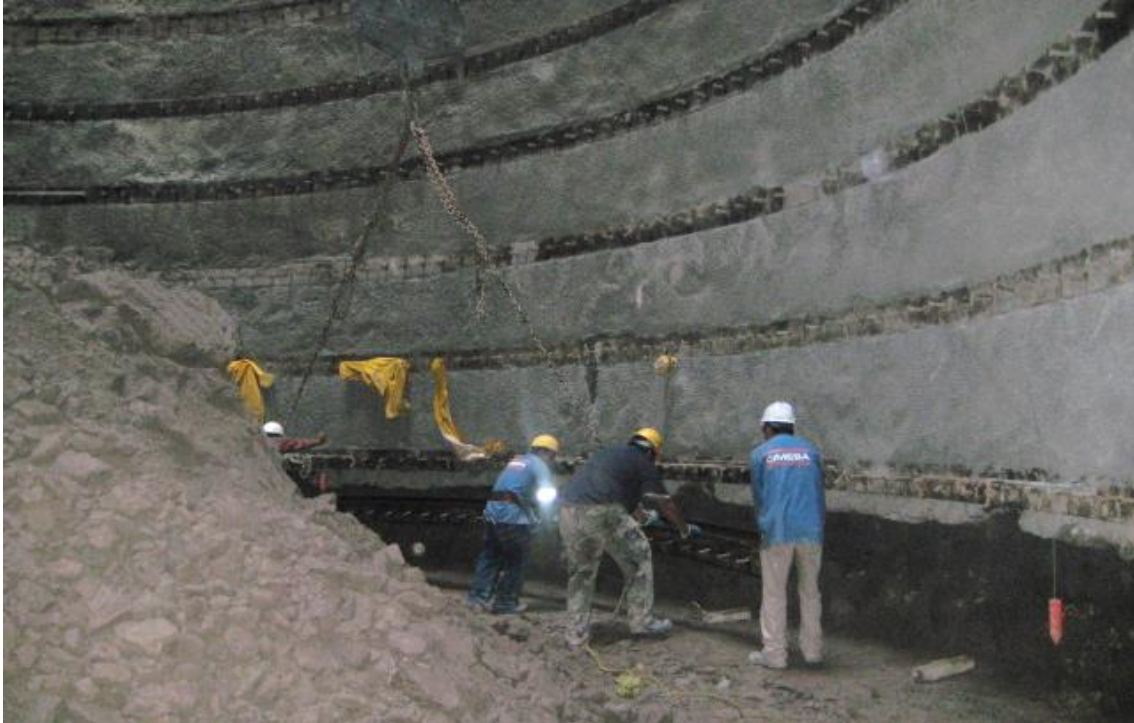
Figura 50. Colocación de marcos metálicos.
