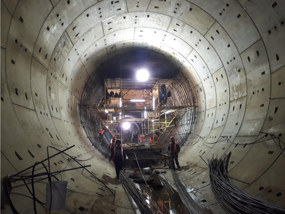
Figura 107. Habilitado de acero de refuerzo para el revestimiento definitivo.
