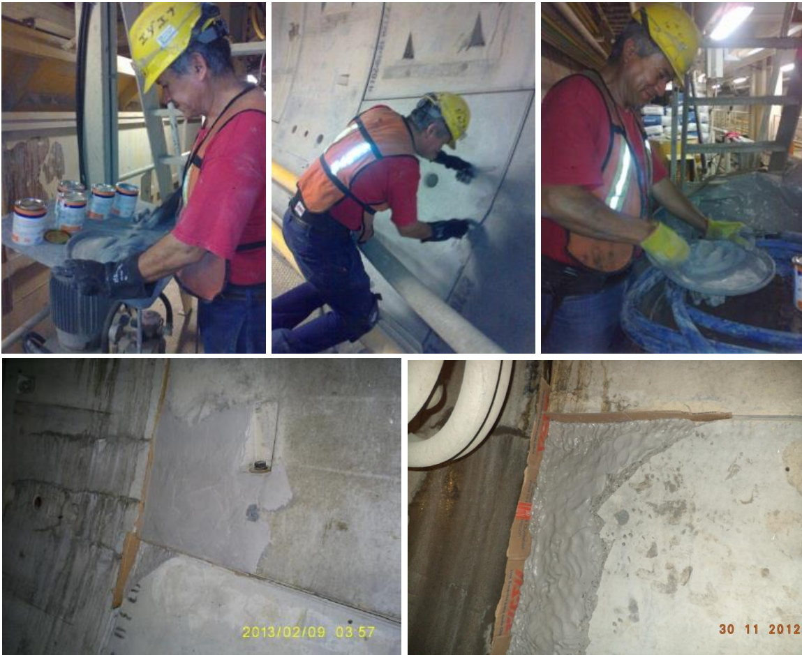
Figura 312. Resane de dovelas.
