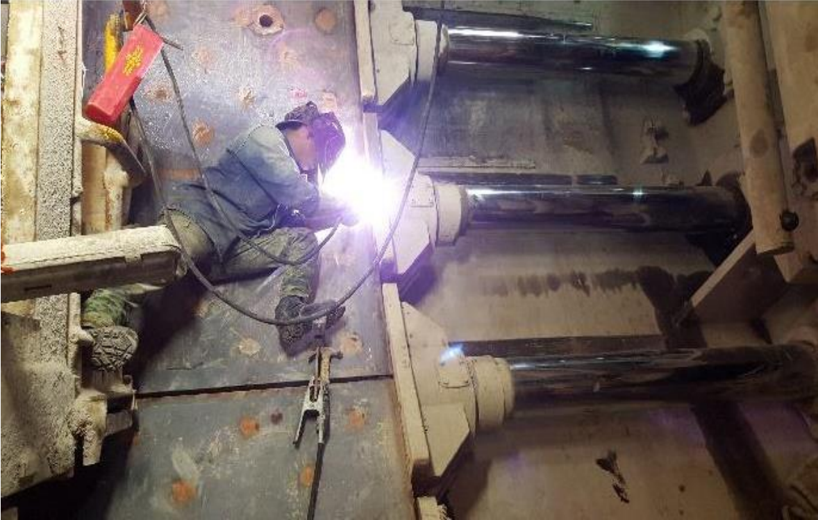
Figura 280. Aplicación de soldadura de unión con pads.
