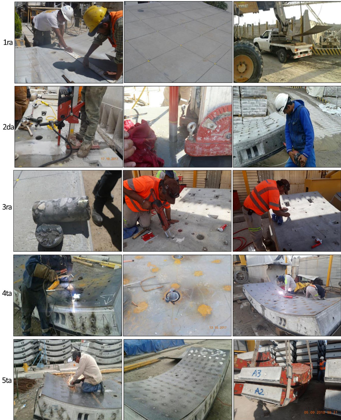
Figura 278. Proceso de recubrimiento metálico de dovelas.
