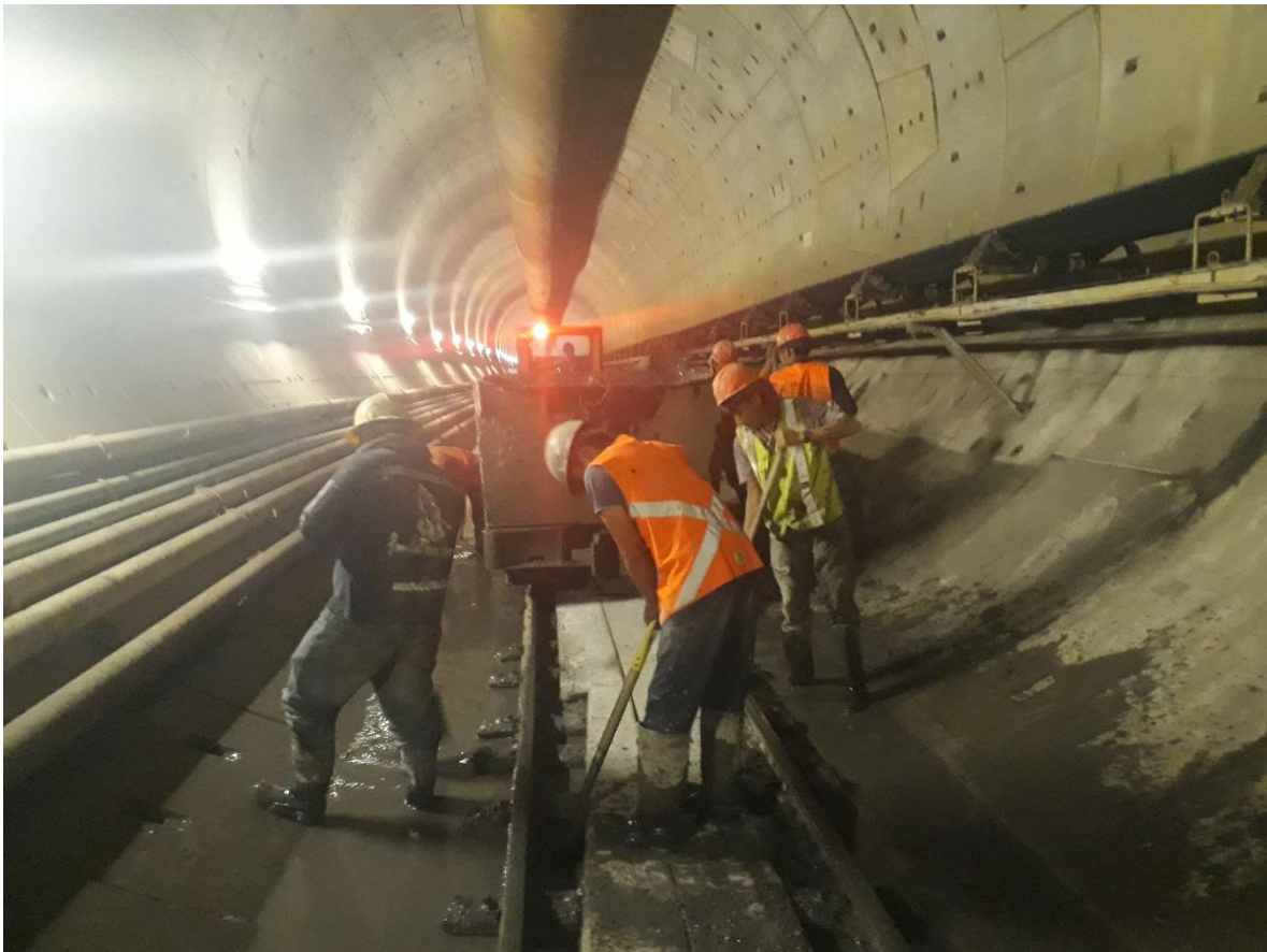
Figura 327. Labores de limpieza en túnel.
