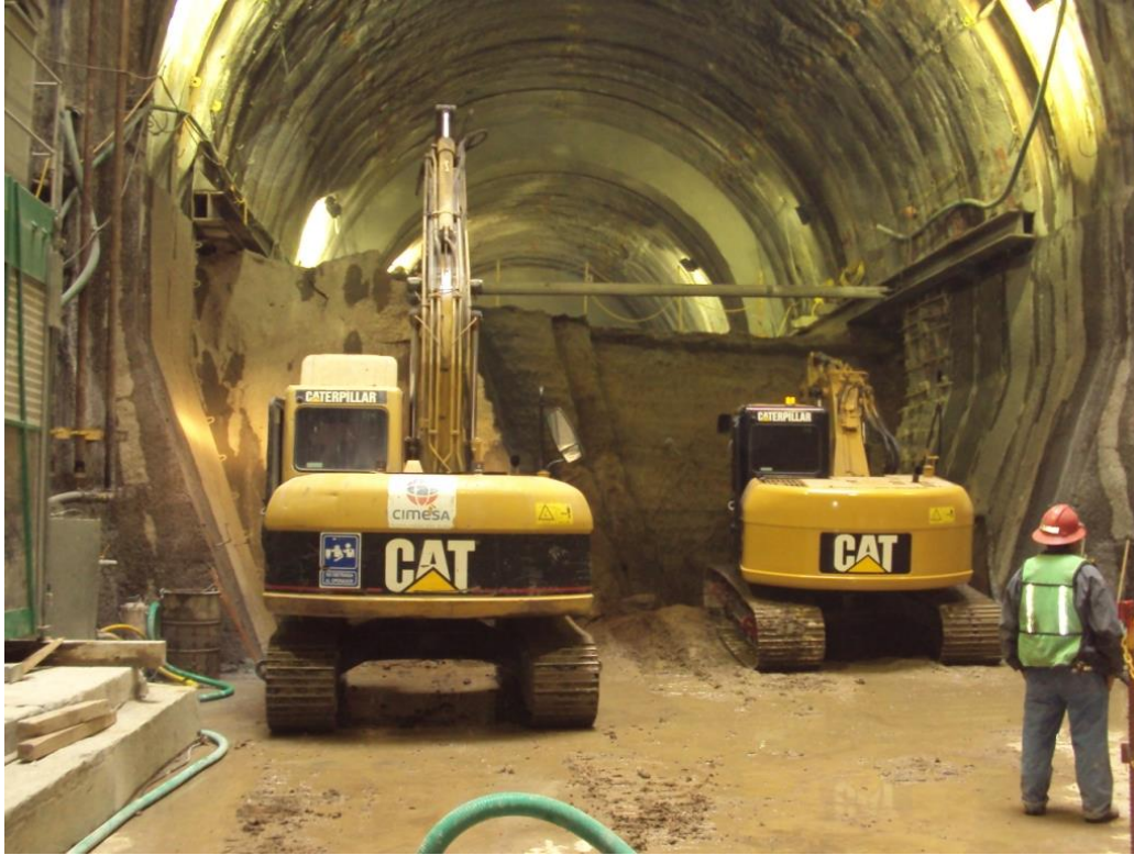
Figura 72. Excavación de la sección media inferior de la galería.
