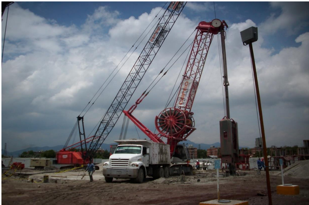
Figura 39. Excavación de muro Milán y acarreo de material.
