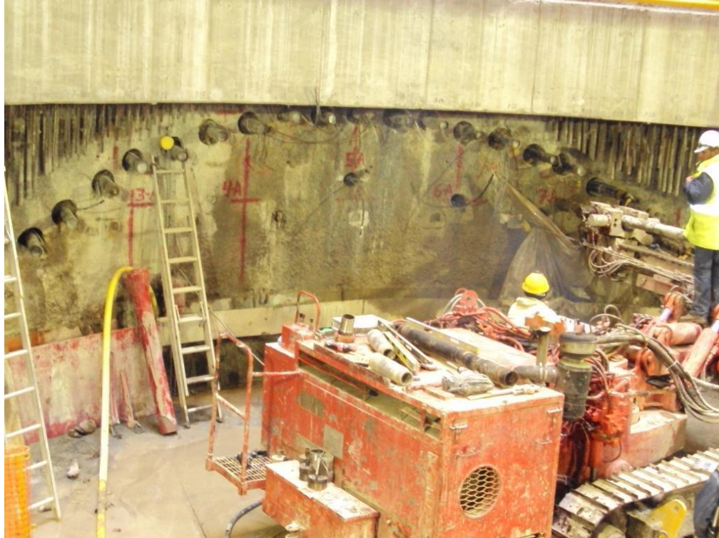
Figura 66. Bóveda de elementos estructurales a base tubos metálicos de 4”.
