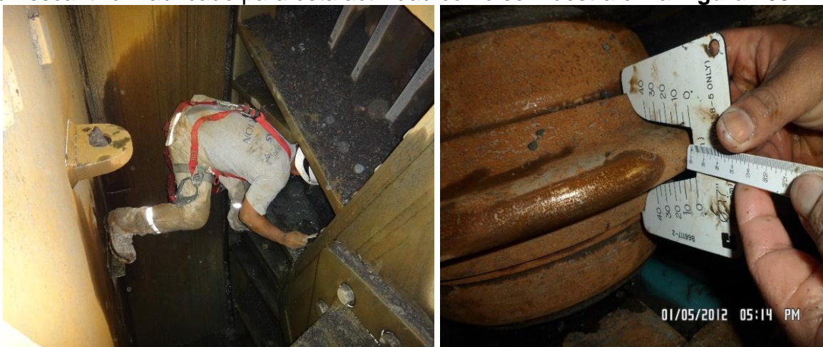
Figura 205. Revisión y medición de desgaste de los discos cortadores.
