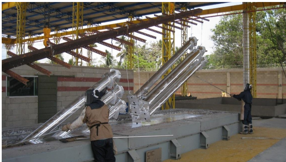
Figura 6.3.3. Galvanización por inmersión en caliente. Procedimiento para proteger piezas de acero mediante su inmersión en baño de zinc a 450°C, formándose una unión metalúrgica. Provee al material una protección anticorrosiva de hasta 20 años. (s.f). Ilustración Galvanizado en Caliente. [Fotografía]. Recuperado de: https://galvanizadoencaliente.wordpress.com/galvanizado
