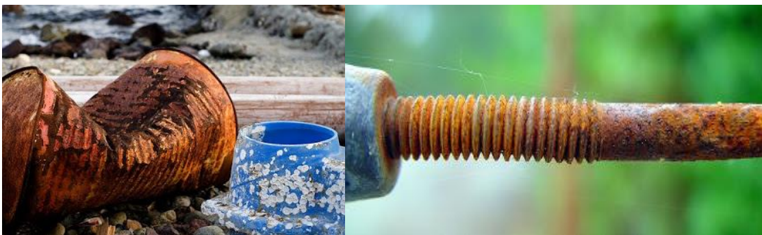
Figura 6.3.1. Corrosión. Proceso de degradación de metales, producto de reacciones espontáneas en base a las interacciones de las condiciones físico-químicas del medio ambiente en el que se encuentra. (2009). Ilustración Oxidación y Corrosión de metales [Figura]. Recuperado de: http://procesosmecanicos.blogspot.com.co/2009/06/sc-asc.html
