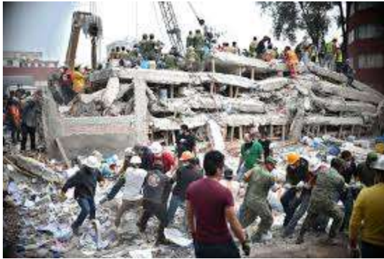
Figura 52. Daños del sismo del 2017 (CNN en español).
