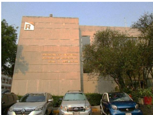
Figura 3.43. Fachada principal, lado poniente del edificio y muro cabecero. Foto 3.
