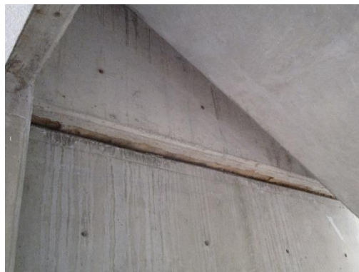
Figura 3.68. Junta constructiva de los muros no estructurales en el 2do Piso.
