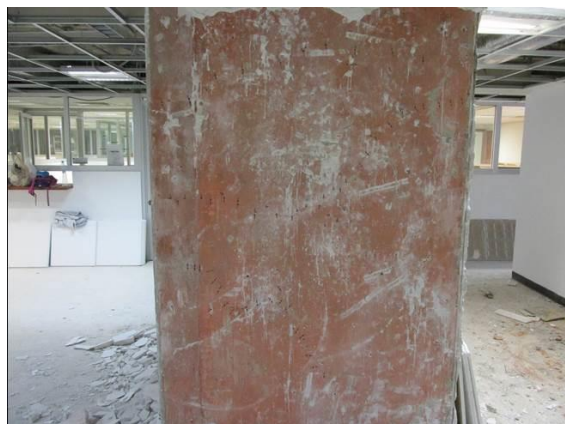
Figura 2.30. Columna de concreto sin acabados. (DE-DICYG, 2018)
