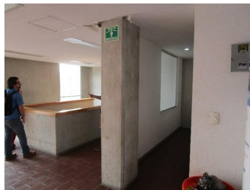
Figura 3.66. Buen estado y conservación de columna en el 2do Piso.
