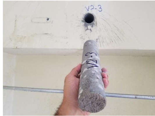
Figura 2.36. Núcleo extraído de trabe de concreto reforzado. (INDECAL, 2019)
