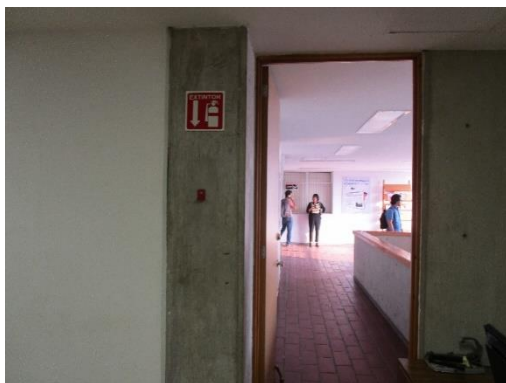
Figura 3.65. Buen estado y conservación de columna en el 2do Piso.
