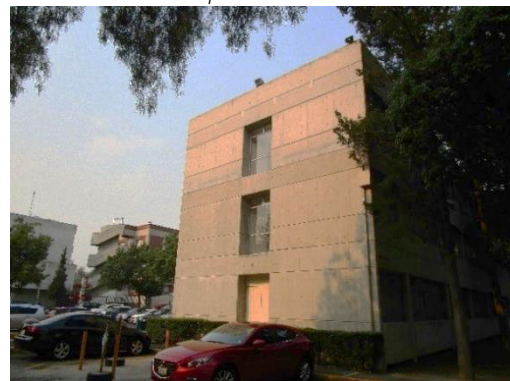
Figura 3.44. Muro cabecero del ala poniente. Foto 4.
