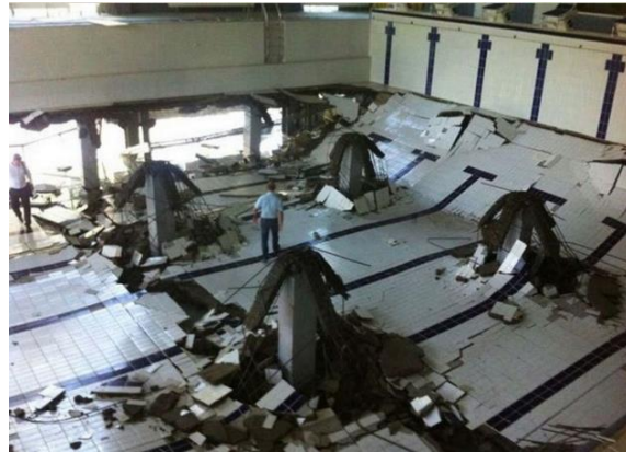
Figura 2.14. Efectos de punzonamiento (blogs.20minutos, 2016)
