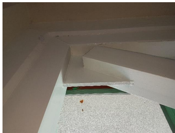
Figura 3.7. Conexión de contraventeos metálicos a la estructura sin daño. (GACONSA, 2018)
