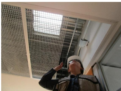
Figura 3.69. Revisión del sistema de techo en el 2do Piso.
