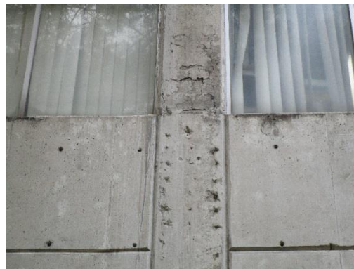
Figura 3.60. Fisuras en unión trabe-columna. Foto 20.
