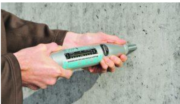
Figura 2.41. Prueba de Esclerómetro en muro de concreto reforzado. (COTECNO, 2019)
