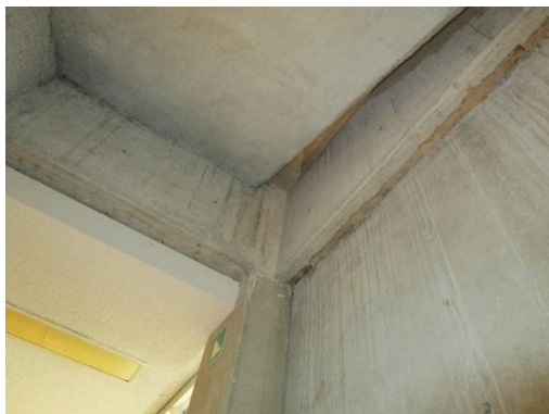
Figura 3.67. Buen estado y conservación de unión trabe-columna en el 2do Piso.
