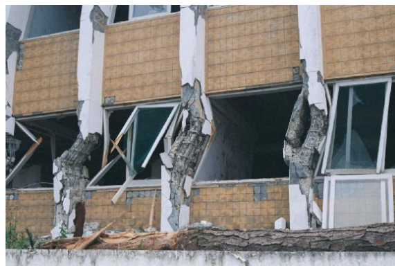
Figura 2.16. Efectos de columna corta. (@Mundo_Hormigon, 2017)
