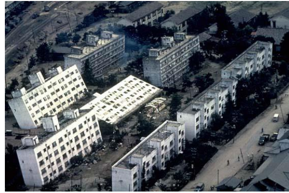
Figura 2.22. Colapso de edificio causado por licuación en arenas. (Onofre, 2012)
