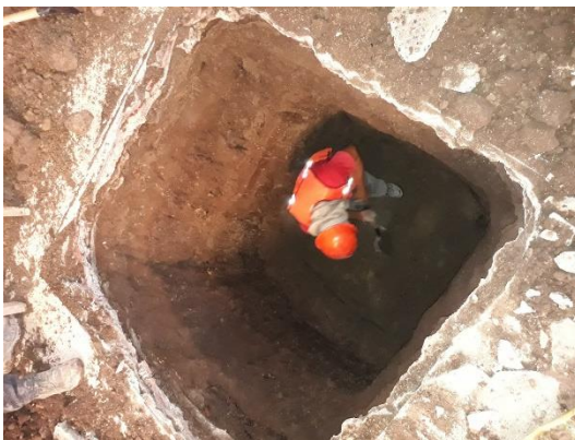
Figura 2.58. Excavación de Pozo a Cielo Abierto (PCA). (CSI Ingeniería, 2019)
