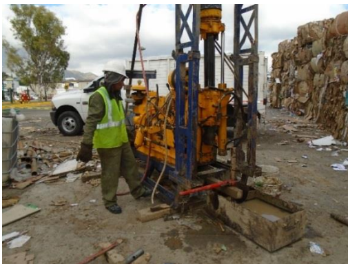
Figura 2.60. Técnicos realizando la Prueba de Penetración Estándar en Suelo. (Geotecnia2000, 2019)
