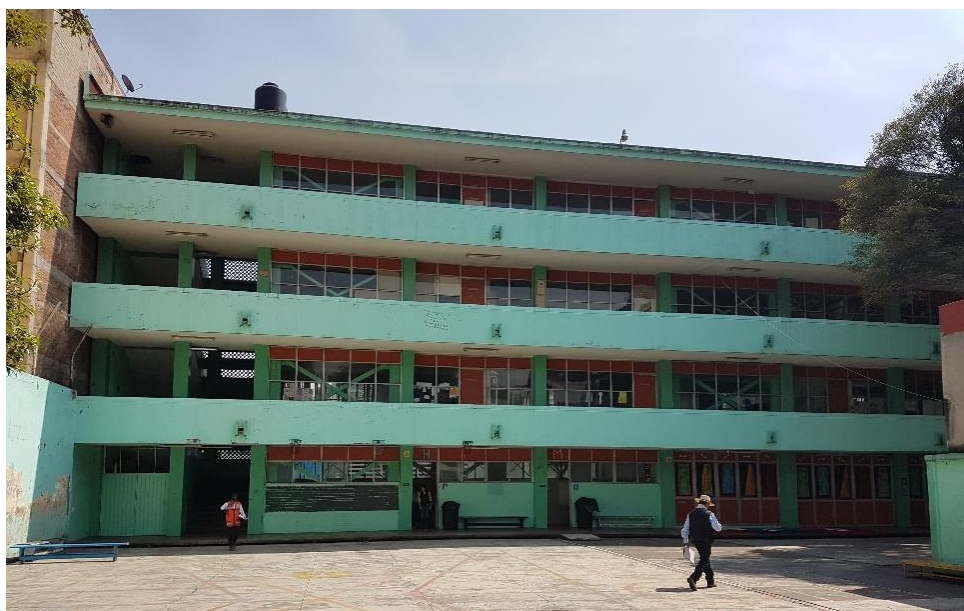
Fig. 3.1. Vista frontal del edificio. (GACONSA, 2018)
