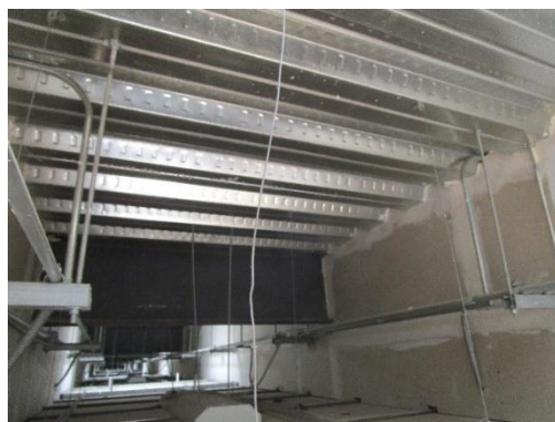
Figura 3.70. Buen estado de las traves secundarias y sistema de techo.
