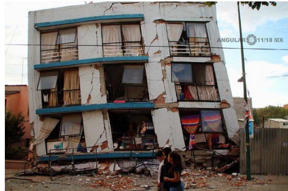
Figura 1.6. Daño severo y derrumbe parcial del edificio de 5 niveles en Saratoga 715, Colonia Portales, Ciudad de México. Vista frontal. (ANGULAR 11-18 MX, 2017)
