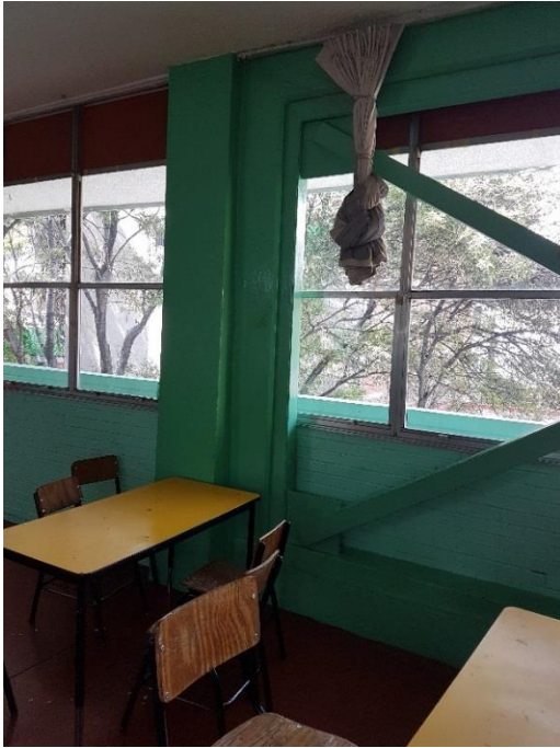
Figura 3.8. Conexión de contraventeos metálicos a la estructura sin daño. (GACONSA, 2018)
