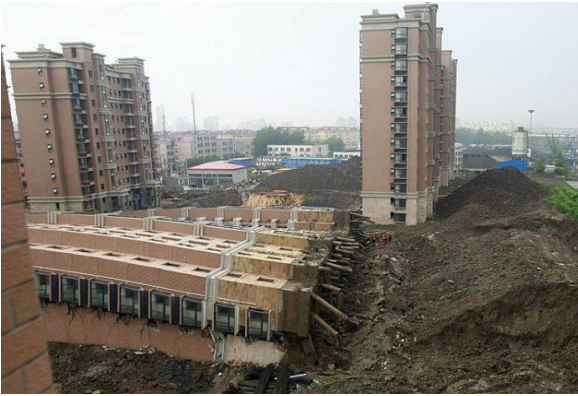
Figura 2.21. Colapso de edificio causado por falla en cimentación profunda. (Pérez, 2009)
