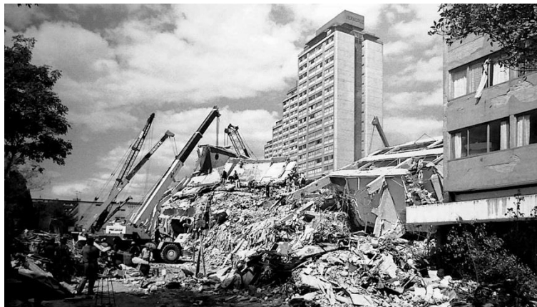
Figura 1.4. Derrumbe del edificio Nuevo León, 1985 en la Ciudad de México. (Protocolo, 2015)
