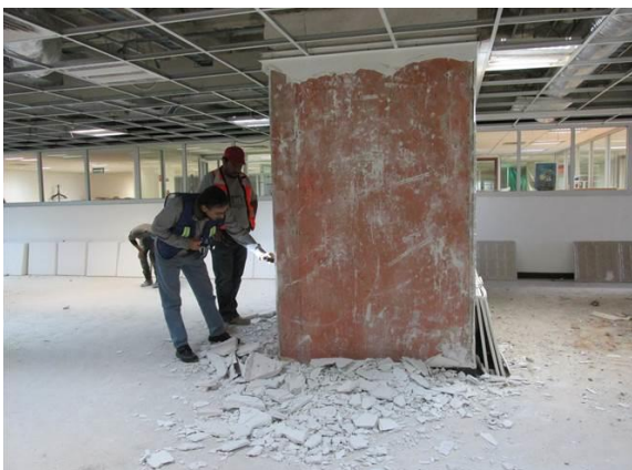
Figura 2.29. Demolición de acabados en columna de concreto. (DE-DICYG, 2018)
