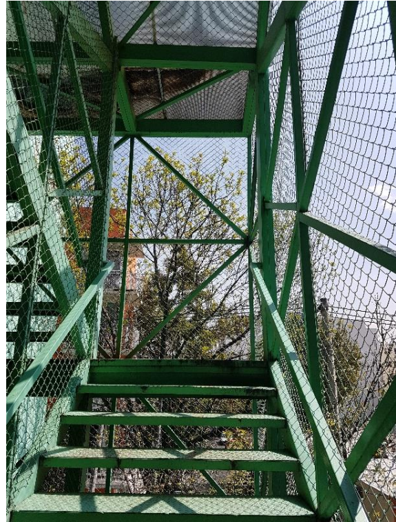
Figura 3.13. Escalera metálica de emergencia del edificio. (GACONSA, 2018)
