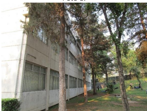
Figura 3.47. Fachada trasera, ala sur. Foto 7
