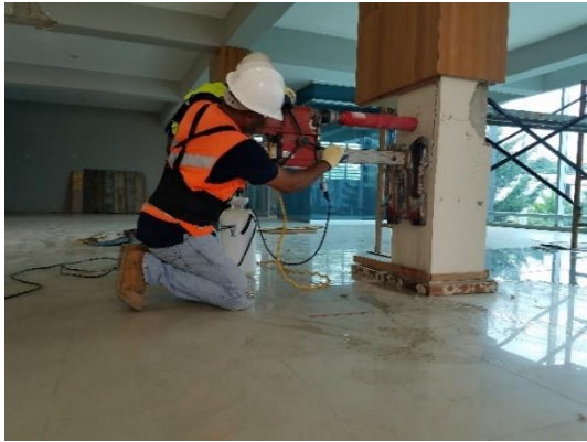
Figura 2.35. Extracción de núcleo de concreto. (INDECAL, 2019)
