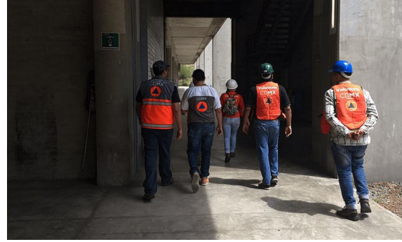
Figura 2.5. Evaluaciones de emergencia realizadas por personal de Protección Civil. (El Big Data, 2017)
