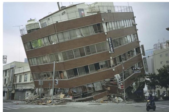
Figura 1.12. Fallas estructurales causadas por alta vulnerabilidad en edificaciones: planta baja flexible. (Christ, 2010)
