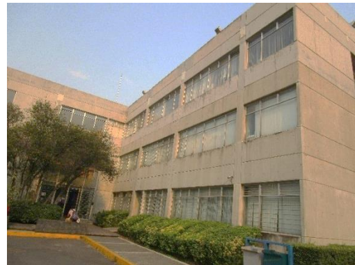
Figura 3.42. Fachada principal, lado norte del edificio. Foto 2.
