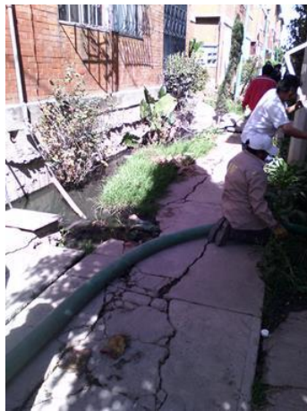
Figura 2.23. Asentamientos en terrenos circundantes. (DE-DICYG, 2018)
