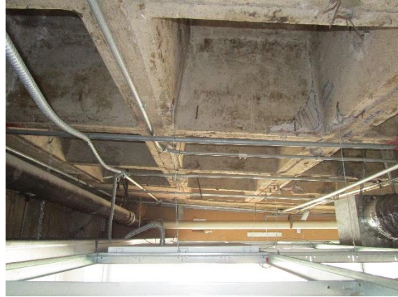
Figura 2.12. Flecha en traves. (DE-DICYG, 2018)
