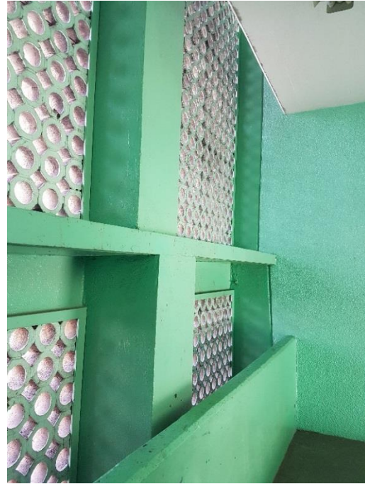
Figura 3.9. Cambio abrupto de sección transversal en columna. (GACONSA, 2018)
