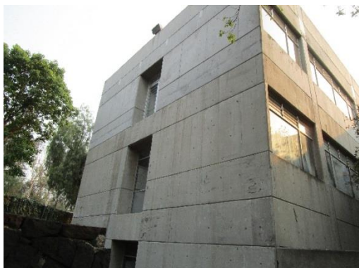
Figura 3.45. Muro cabecero del ala suroriente. Foto 5.
