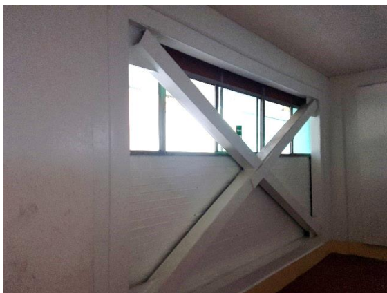
Figura 3.6. Configuración de contraventeos metálicos. Sin daño. (GACONSA, 2018)
