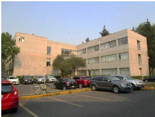
Figura 3.41. Fachada principal del edificio. Foto 1.
