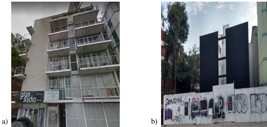
Figura 3.22. Descripción del edificio BJ-84 – Colapso: a) Vista del edificio antes del sismo del 2017 y b) Vista del edificio posterior al sismo y a los trabajos de obra.
