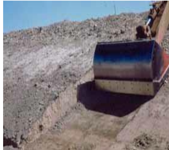
Figura 4.2.- Primer recorte con retroexcavadora de la capa protectora de humedad
