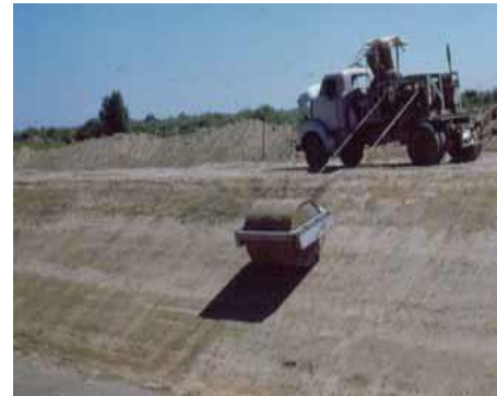
Figura 4.4. Compactado de taludes, peso de una tonelada
