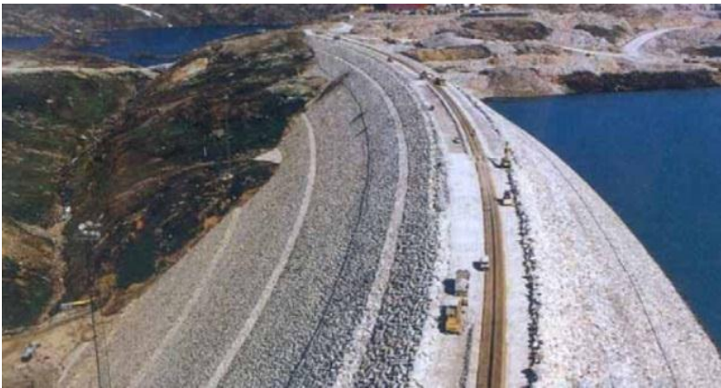
Figura 4.2.4.- Aquí se observa el núcleo de concreto asfáltico en su fase final.
