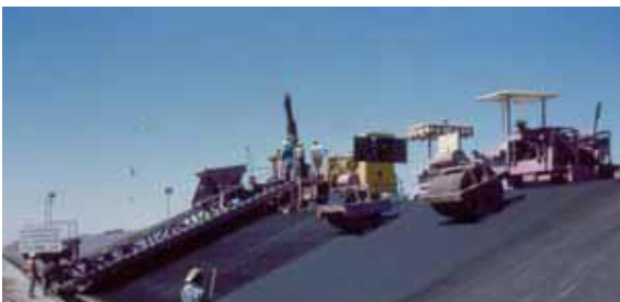
Figura 4.8.- Compactado del concreto asfáltico en el talud con los rodillos.
