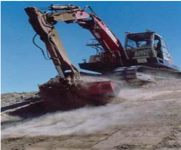
Figura 4.1.- Retroexcavadora efectuando el primer recorte del terreno natural (arcilloso y limoso)
