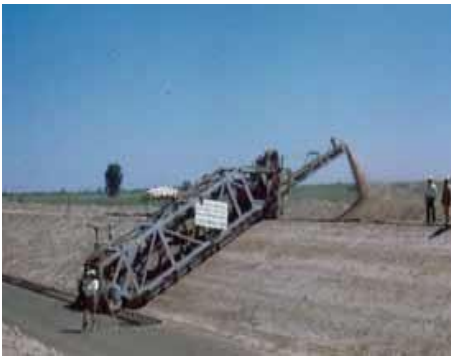
Figura 4.3.- Afine de terracerías con recortadora de cangilones
