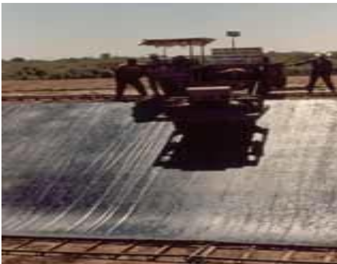
Figura 4.10.- Se observa la plasticidad del concreto asfáltico
