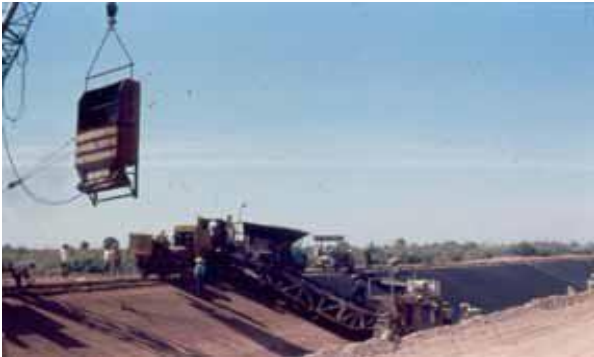
Figura 4.7.- Extendido de la mezcla asfáltica.
