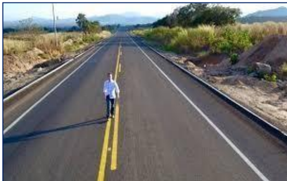
Figura 8.- Carpeta flexible de concreto asfáltico
