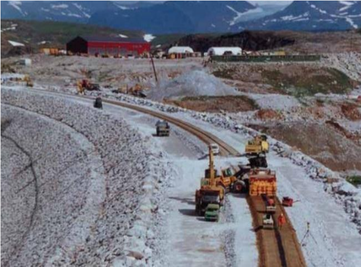
Figura 4.2.3.- Se observa la compactación del núcleo de concreto asfáltico
