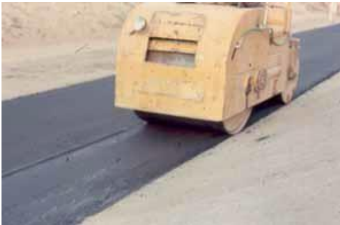
Figura 4.12.- Compactación del concreto asfáltico en la base
