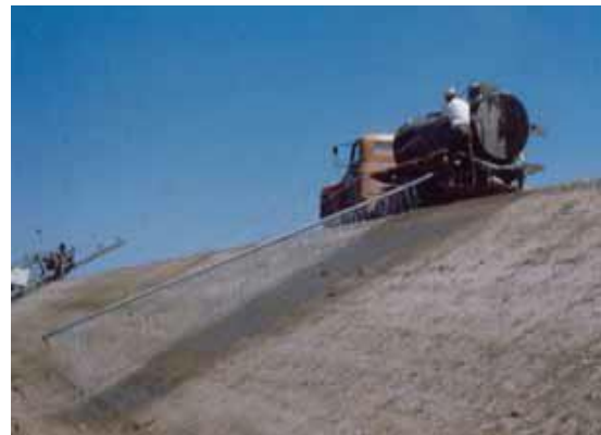
Figura 4.6.- Riego de terracerías con esterilizante y agua para facilitar la compactación complementaria
