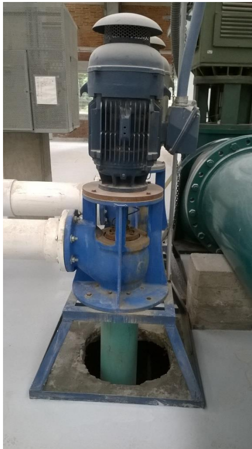
Fotografía 1.10 Bomba con velocidad de operación de diseño de 1700 \text{ rpm}
