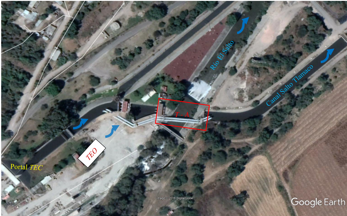
Fotografía 1.1 Entorno del Túnel - Alcantarilla (T - A) .
