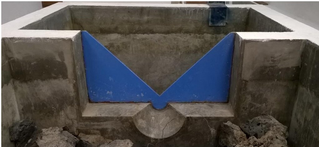
Fotografía 1.12 Vertedor de pared delgada y forma triangular ( 90^\circ )
