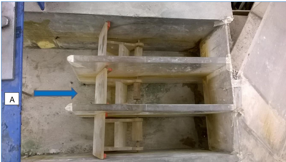
Fotografía 1.5 Tramo en la entrada del Túnel - Alcantarilla
