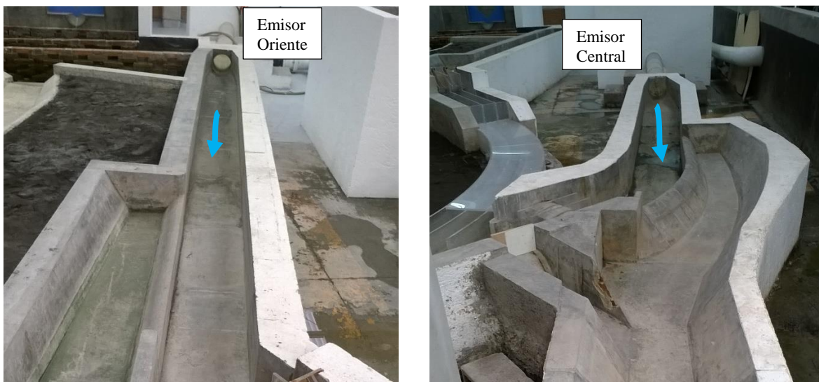
Fotografías 1.2 Portales de salida de los túneles emisores
